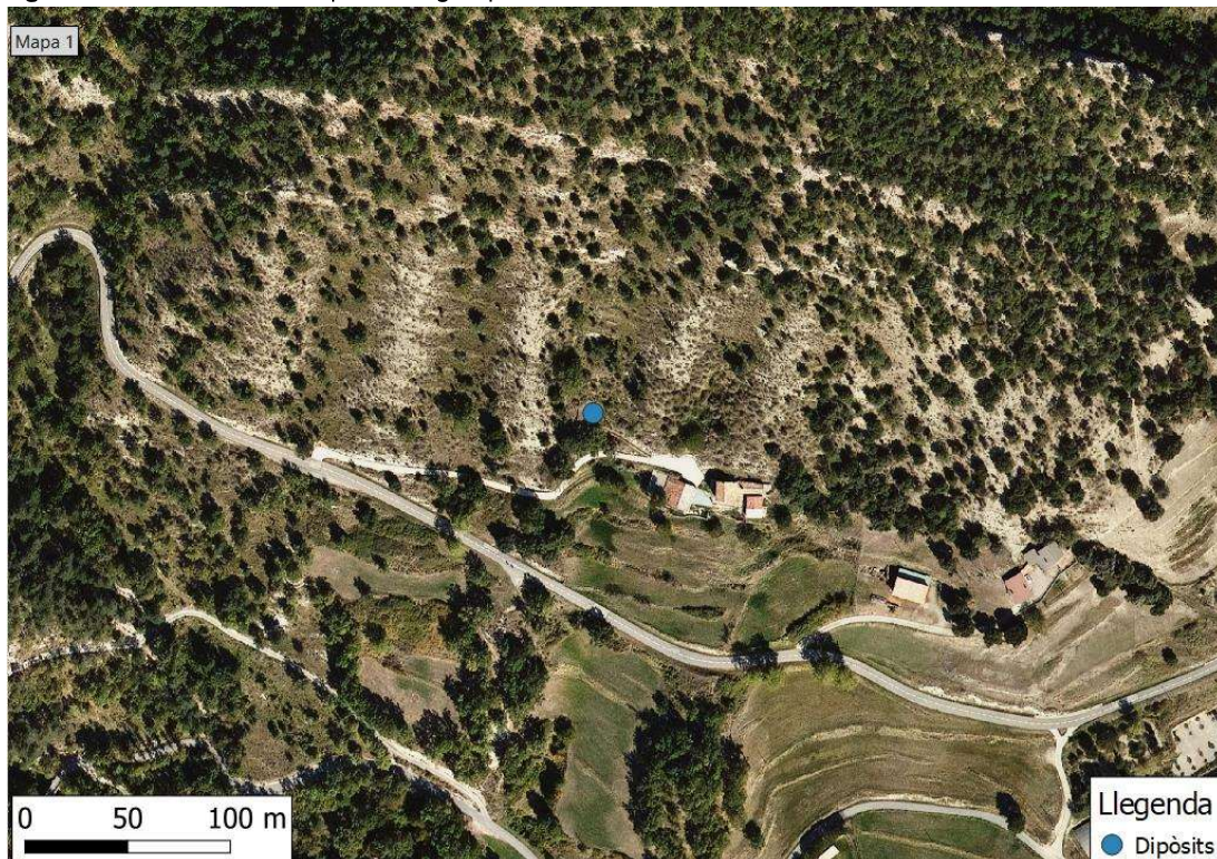
Figura 4. Localització del dipòsit d'aigua potable i la seva sala annexa de cloració.
