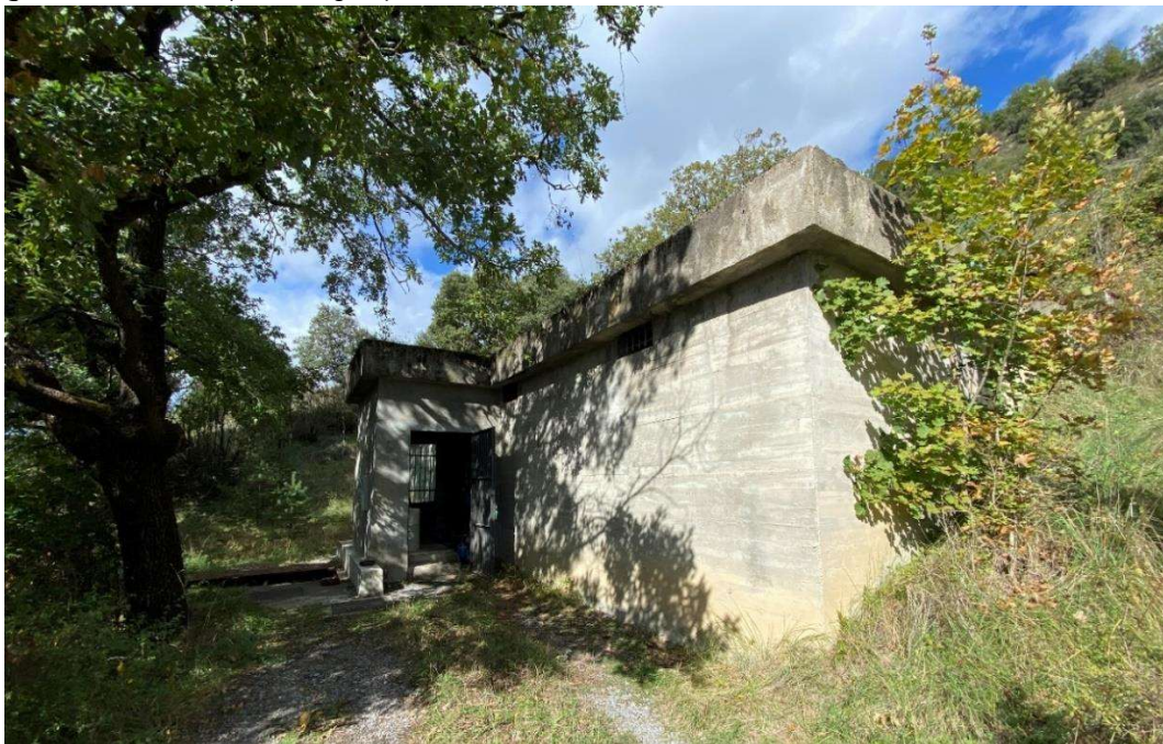
Figura 5. Vista del dipòsit d'aigua potable i la seva sala annexa de cloració.
