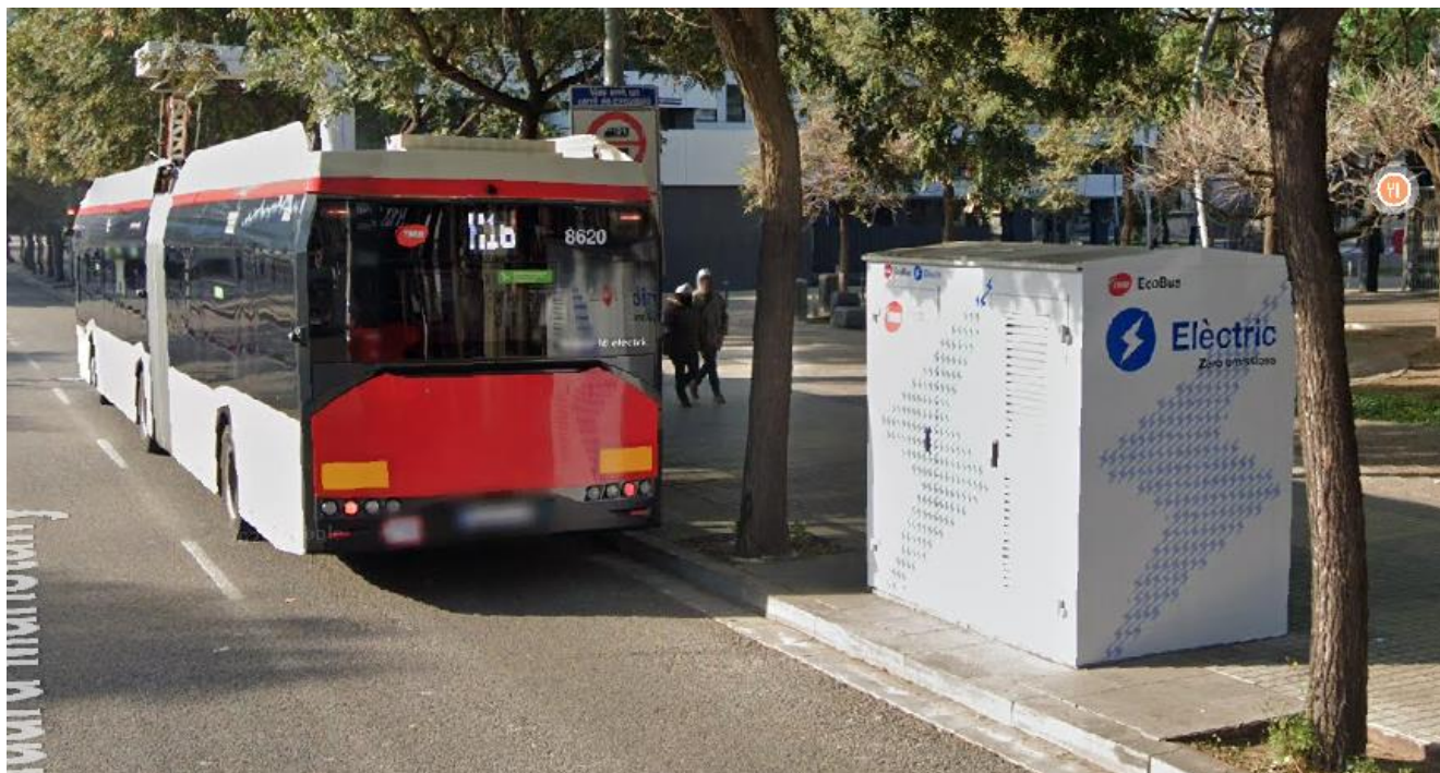
Figura 2. Armari envoltant de recàrrega actual a substituir.
