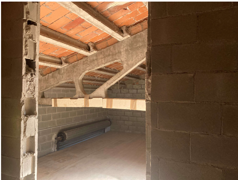
Punt d'ubicació del nou mòdul per a l'inversor i quadres de protecció CC i CA (penjat a paret existent)
