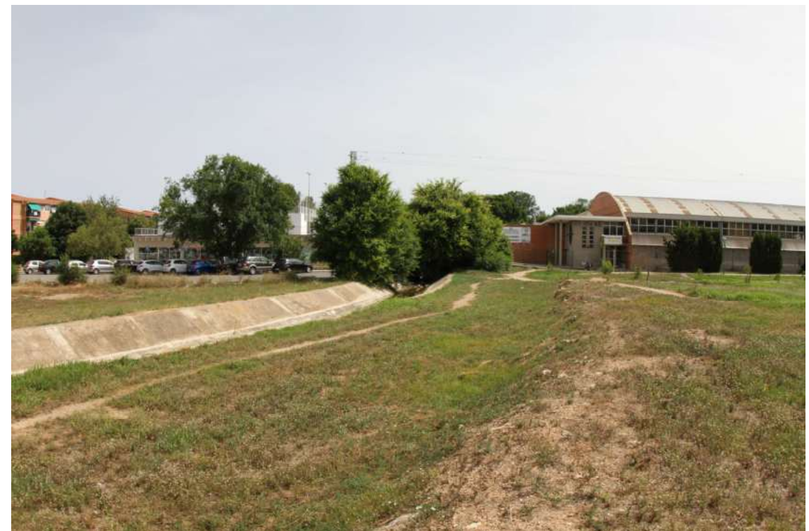
Foto. Vista de la terrassa existent al costat esquerre (oest) de la canalització del Riu Clar, que actualment no forma part de la zona verda.
