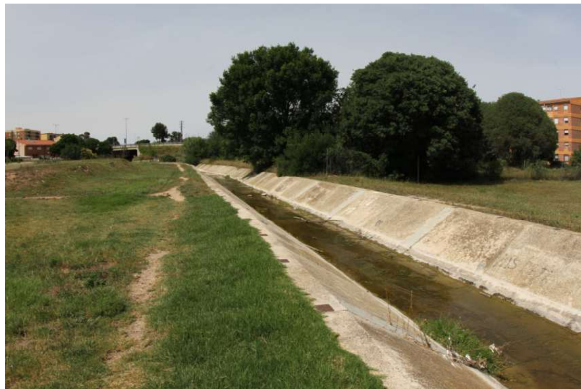
Foto. Tram canalitzat del riu Clar en l'àmbit d'estudi, mirant cap al nord. Al fons a la dreta, arbrat existent a una parcel·la abandonada que no forma part de l'àmbit d'estudi.
