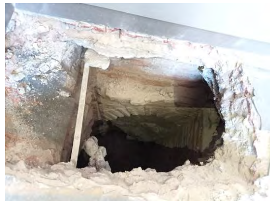
Imatge 7-37. Cala de fonamentació en planta soterrani
