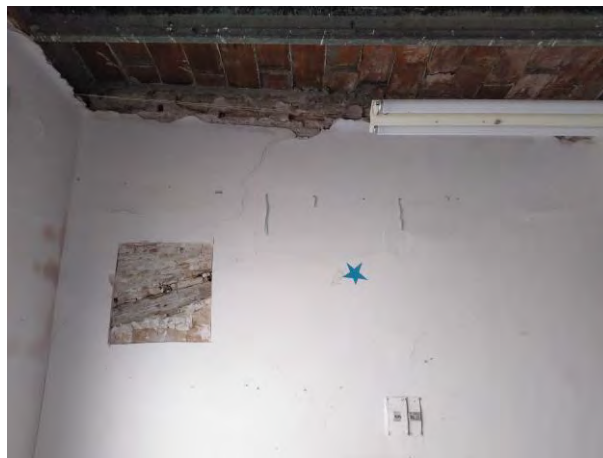
Imatge 7-52. Retirada de revestiment en esquerdada en acabat de paret mitgera
