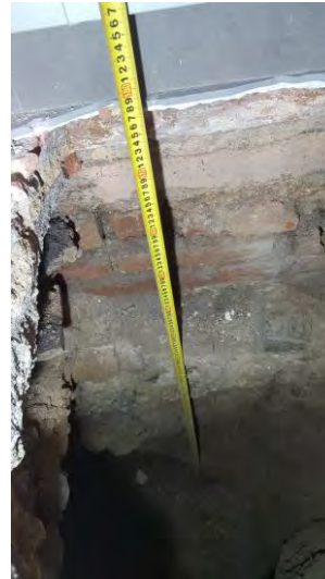
Imatge 7-39. Cala de fonamentació en planta soterrani
