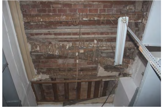
Vistes de l'entramat de planta primera
