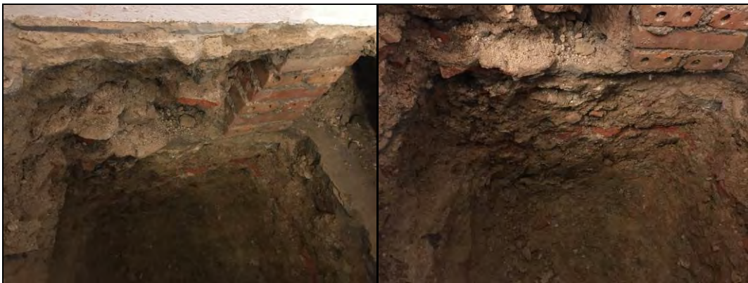
Imatge 6-1. Vista dels fonaments a la zona de soterrani.
