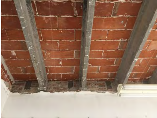
Imatge 7-24. Forjat de biguetes prefabricades armades en sostre de planta segona
