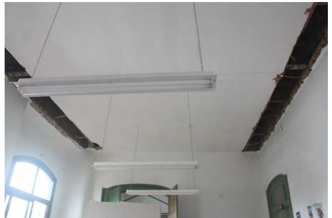
Vistes de l'entramat de planta primera
