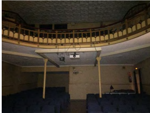
Imatge 7-13. Estructura vertical interior en teatre
