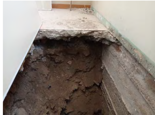
Imatge 7-35. Cala de fonamentació en planta soterrani
