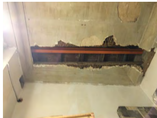
Imatge 7-23. Jàssera metàl·lica en sostre de planta primera
