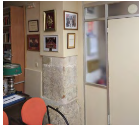
Imatge 7-10. Pilastra de carreu observada al sostre de planta baixa
