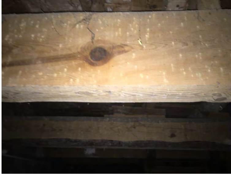
Imatge 5-12. Estructura de reforç en l'escenari del teatre
