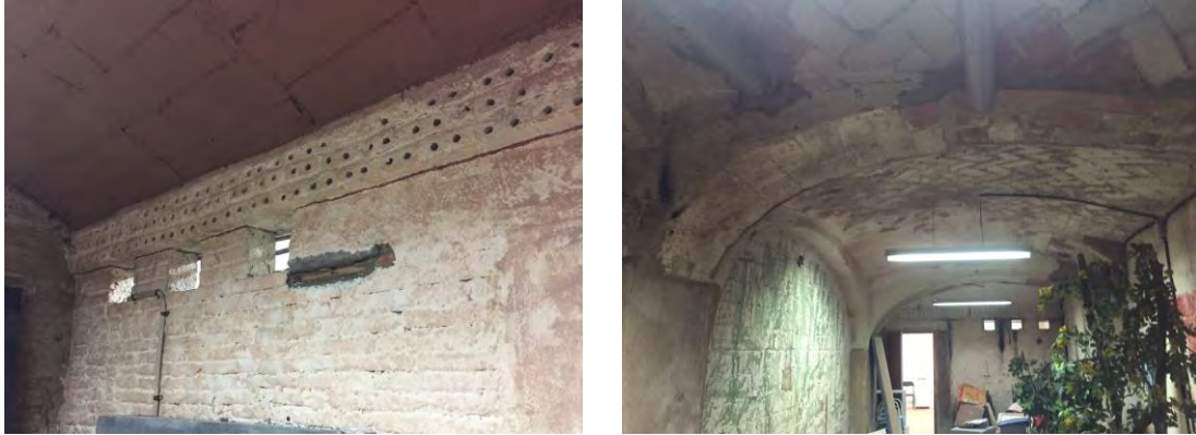
Imatge 7-4. Murs de càrrega interiors en sostre de planta soterrani
