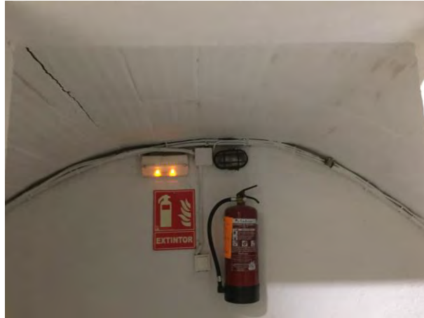
Imatge 7-53. Esquerda en volta de fàbrica en sostre de planta soterrani
