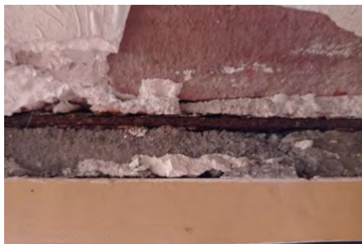
Imatge 7-51. Jàssera amb corrosió amb exfoliació
