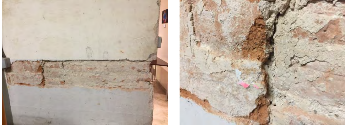
Imatge 7-12. Situació pilastra observada al sostre de planta baixa
