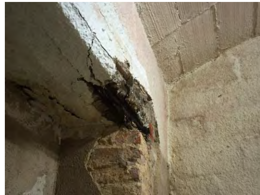
Imatge 7-8. Pilastres de maó massís en sostre de planta soterrani
