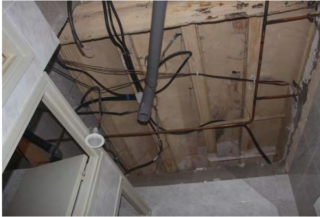
Vistes de l'entramat de planta baixa
