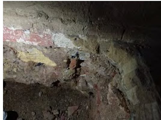
Imatge 7-33. Cala de fonamentació en planta soterrani
