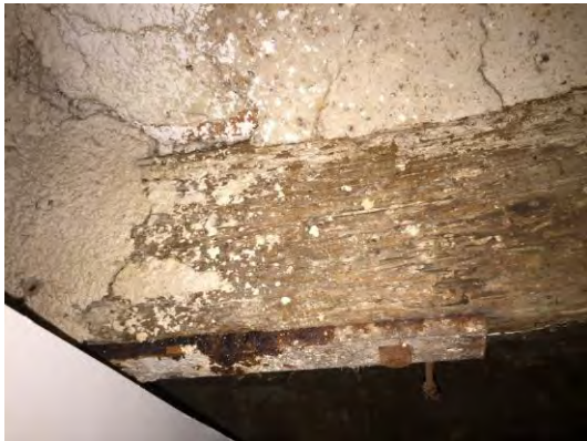
Imatge 7-26. Forjat de fusta serrada en sostre de planta soterrani
