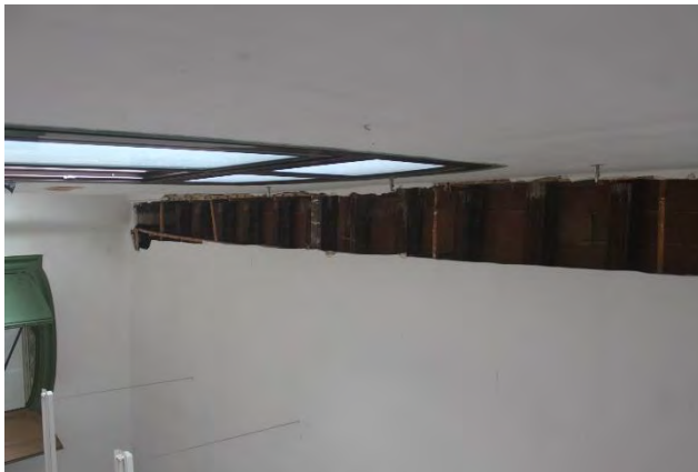
Vistes de l'entramat de planta primera
