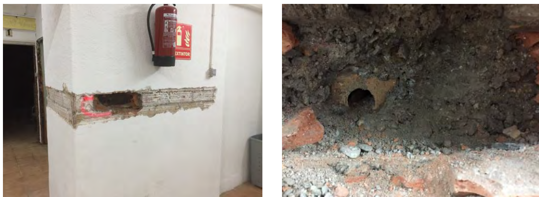
Imatge 7-6. Imatges de cala efectuada en pilastra de planta soterrani
