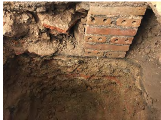
Imatge 7-29. Cala de fonamentació en planta soterrani
