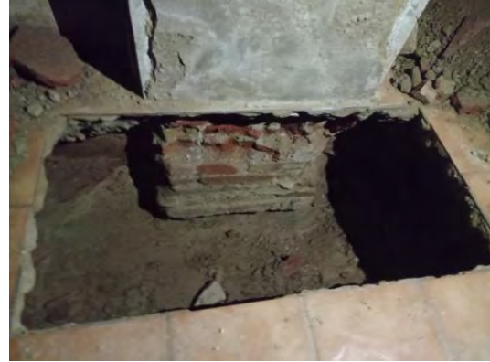
Imatge 7-31. Cala de fonamentació en planta soterrani
