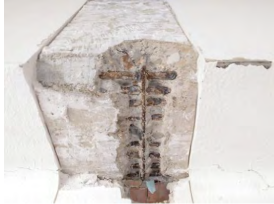
Imatge 7-25. Jàssera de cantell de formigó armat en sostre de planta segona
