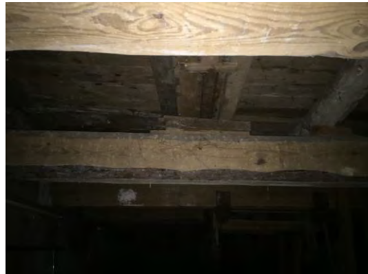
Imatge 7-26. Forjat de fusta serrada en sostre de planta soterrani
