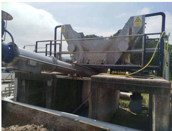
Diferents vistes dels tamisos i compactador actual, les connexions hidràuliques i la ubicació d'elements.
