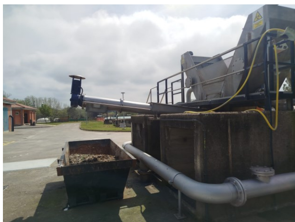
Diferents vistes dels tamisos i compactador actual, les connexions hidràuliques i la ubicació d'elements.
