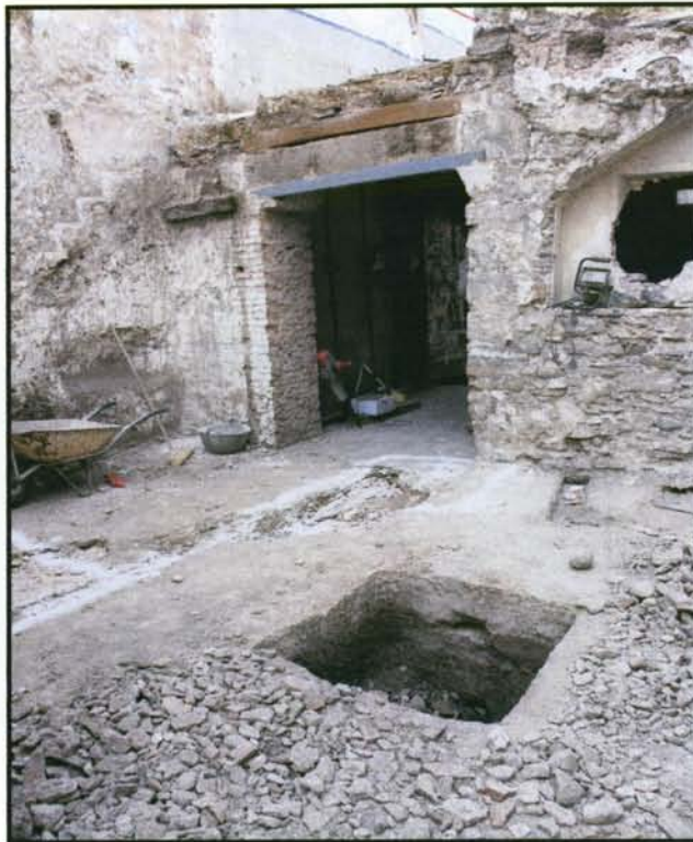
Foto 1. Vista general del pou des del nord-est.
