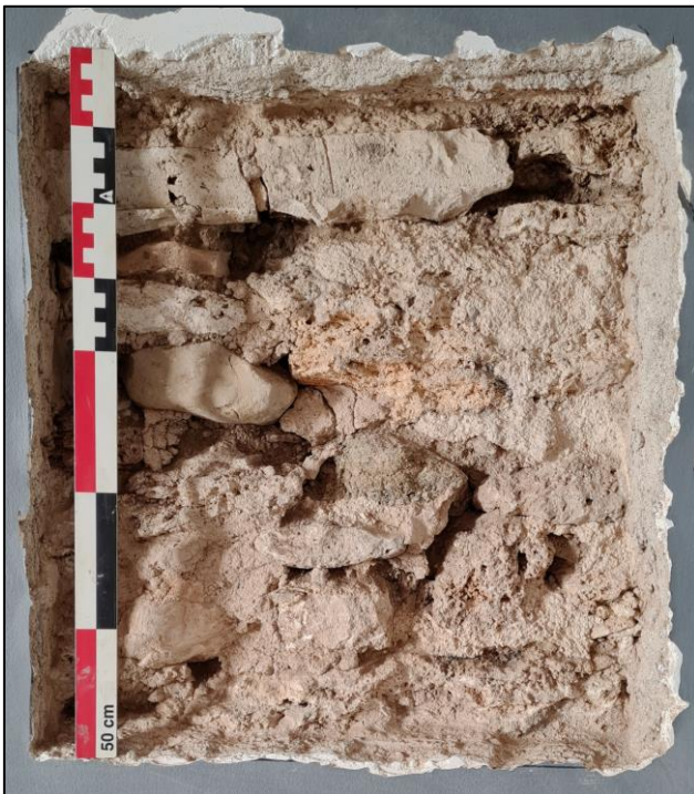
Figura 77. Fotografia del parament de pedra de la cala 9
