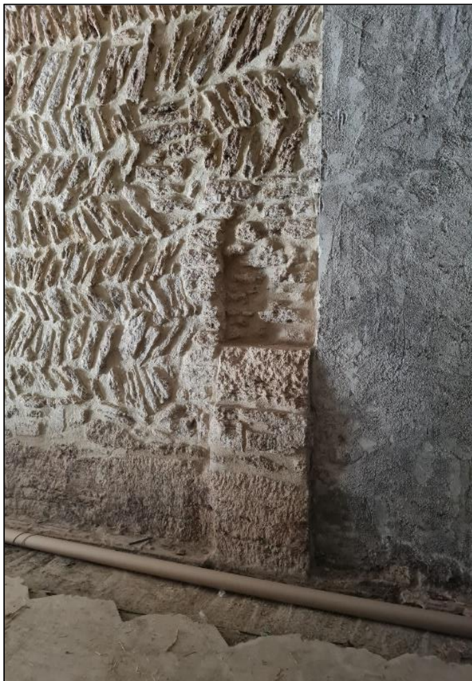
Figura 7. Detall del parament d' opus spicatum i arrencament d'arcada a la planta baixa
