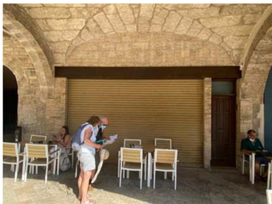
Estat inicial de la façana interior del porxo
