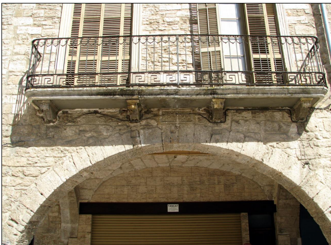
Figura 20. Vista de l'arc del porxo i el balcó de la primera planta amb la localització del baix relleu a sota. ACPE_180001030023698
