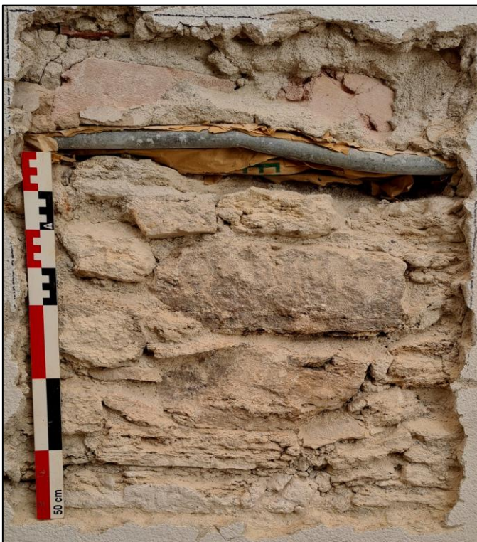
Figura 81. Fotografia del parament de pedra de la cala 10
