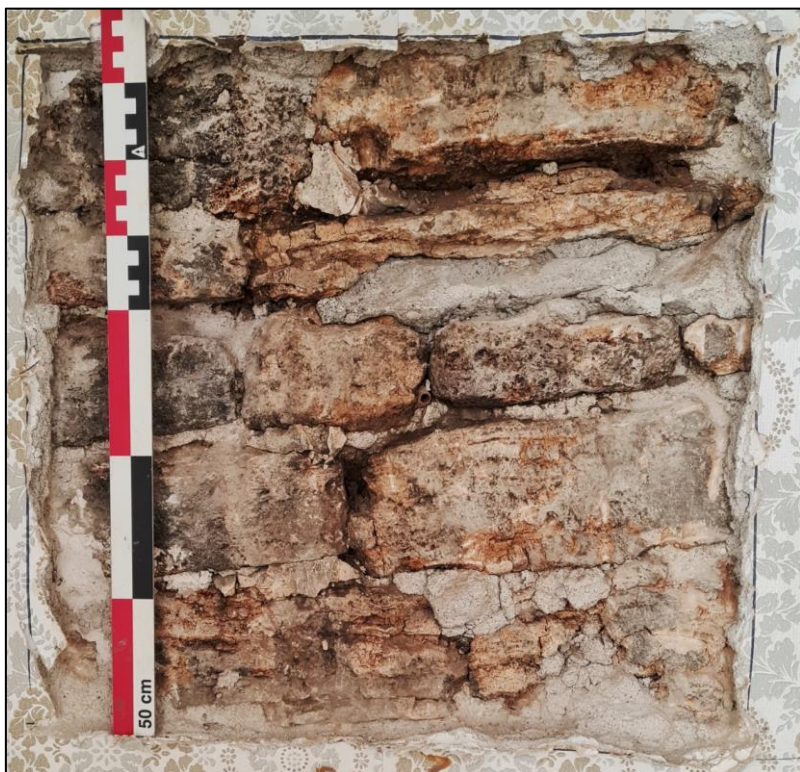
Figura 84. Fotografia del parament de pedra de la cala 11
