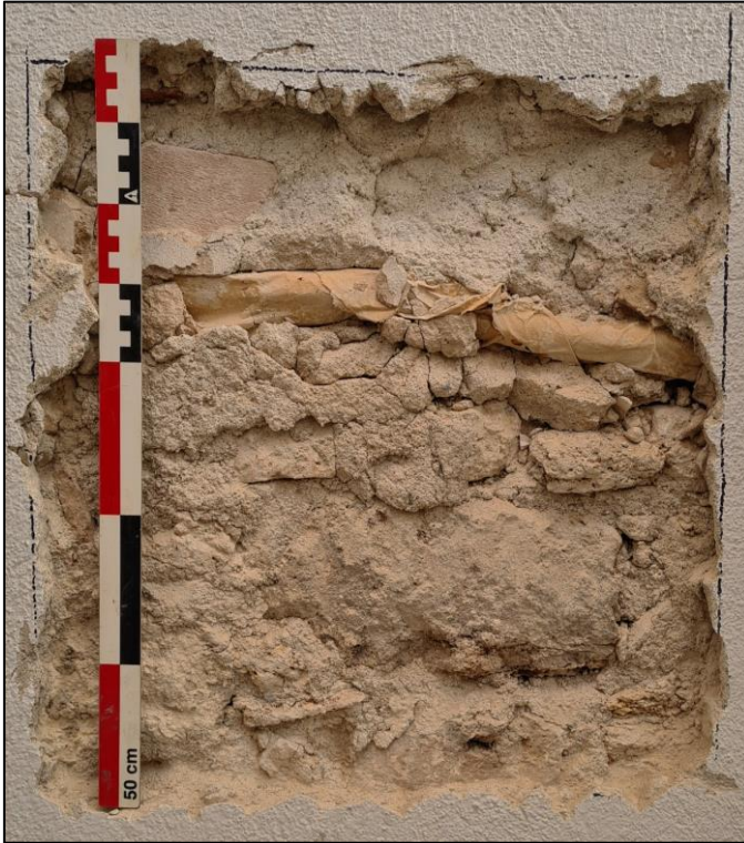
Figura 80. Fotografia de la capa de morters de la cala 10
