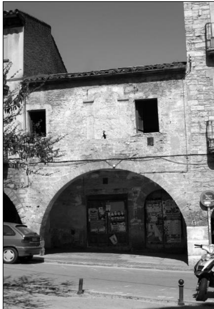
Figura 10. Façana de can Moliner
