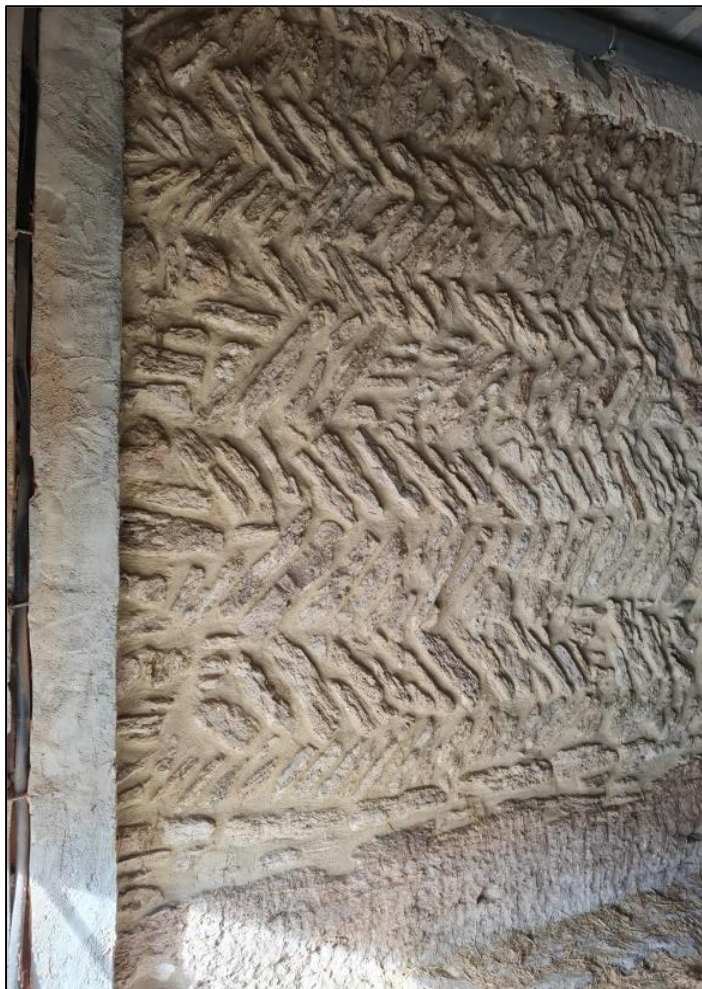
Figura 52. Detall del parament en opus spicatum
