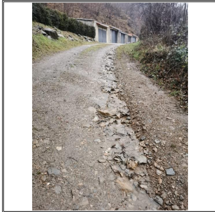
Figura 2. Vista de l'accés als serveis bàsics de Còll on cal construir el paviment de formigó. Gener 2025.
