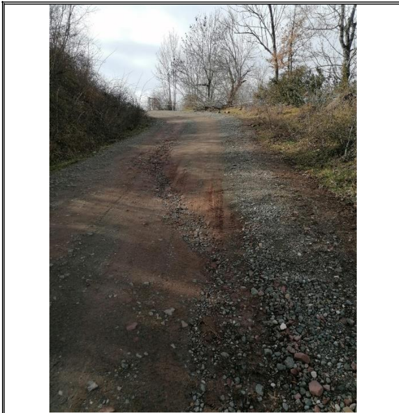
Figura 6. Vista de l'accés d'Erta on cal nivellació i compactar el terreny amb aportació de tot-u. Gener 2025.
