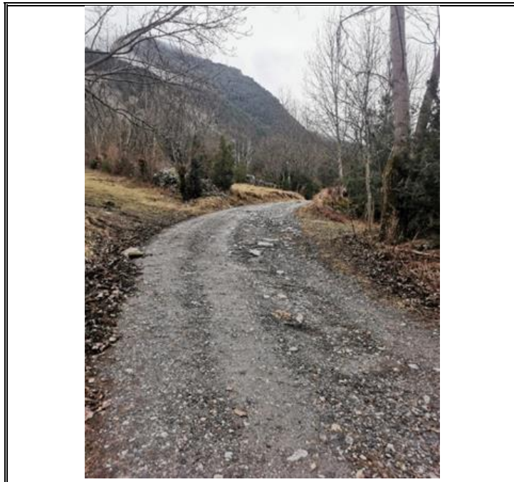
Figura 3. Vista de l'accés de Cierco-Artiga on cal construir el paviment de formigó. Gener 2025.
