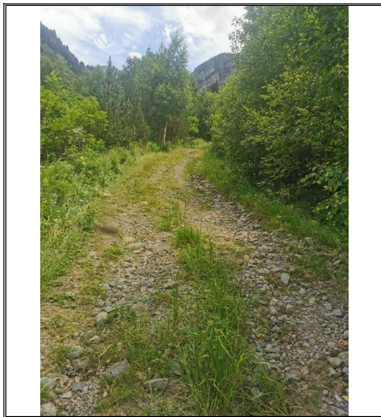
Figura 4. Vista de l'accés als serveis bàsics del Pla de l'Ermita, Taüll i Boí on cal nivellació i compactació del terreny. Juliol 2024.
