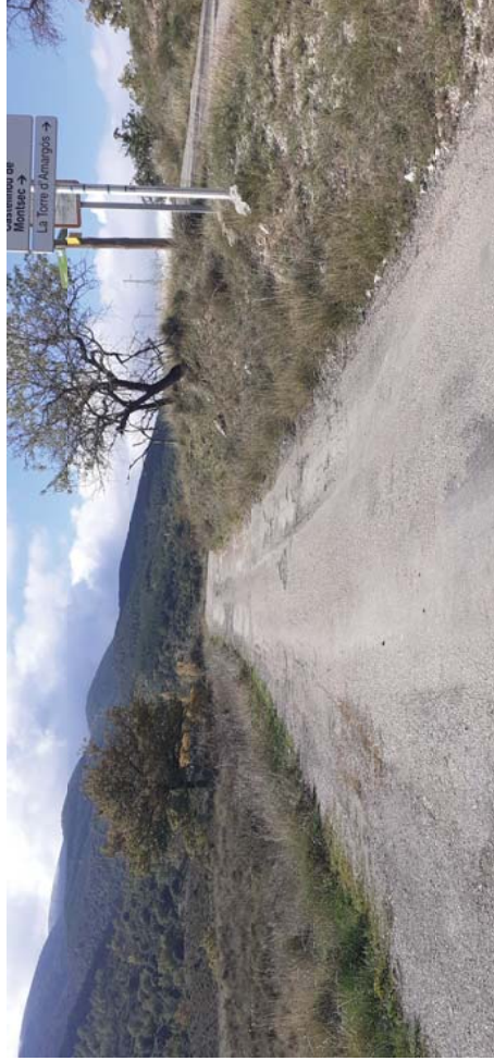
Vista del camí passada la cruïlla amb el camí de Sant Esteve de La Sarga a Castellnou de Montsec, amb el doble tractament força deteriorat.
