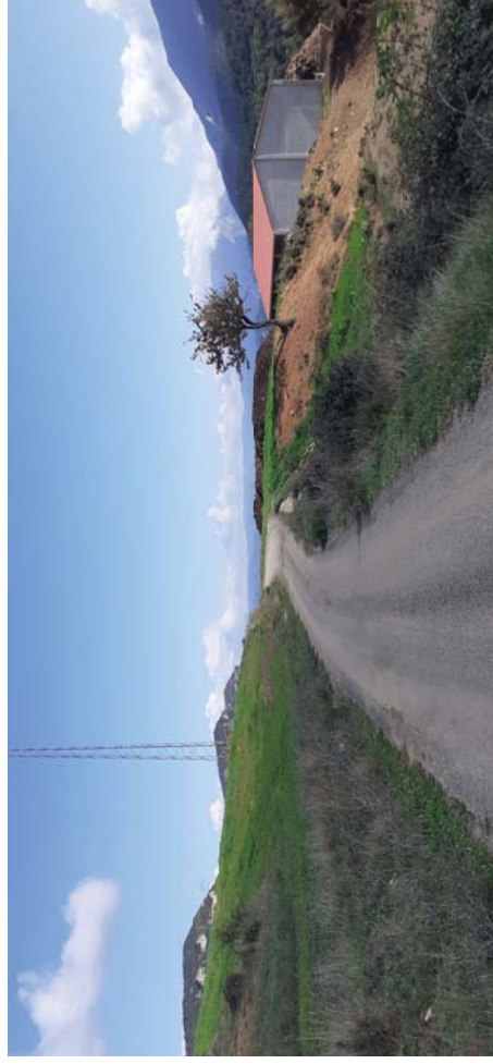
Vista del camí passada la cruïlla amb el camí de Sant Esteve de La Sarga a Castellnou de Montsec, amb el doble tractament força deteriorat.
