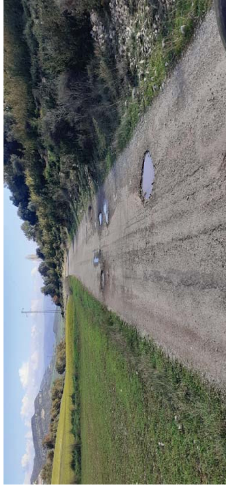
Vista del camí passada la cruïlla amb el camí de Sant Esteve de La Sarga a Castellnou de Montsec, amb el doble tractament força deteriorat.
