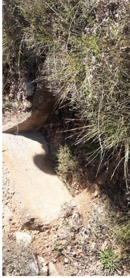
Vista d' una obra d'edrenatge transversal per recollir l' aigua superficial de la cuneta.
