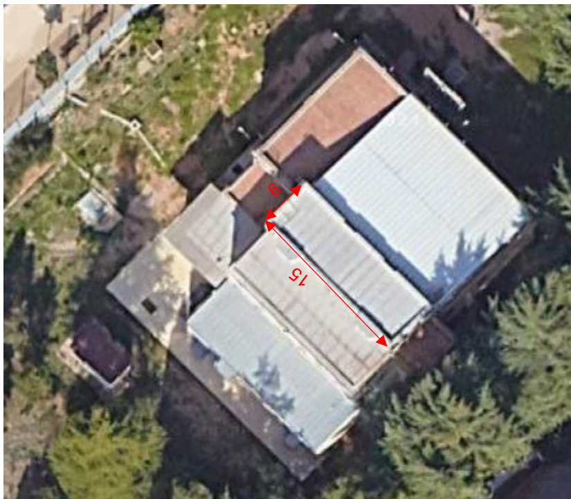
Imatge 8 Coberta superior St.Cugat
