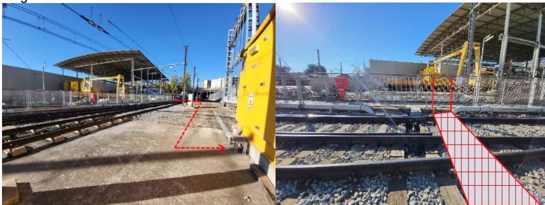
Imatge 10 Accés Subestació Rubí
