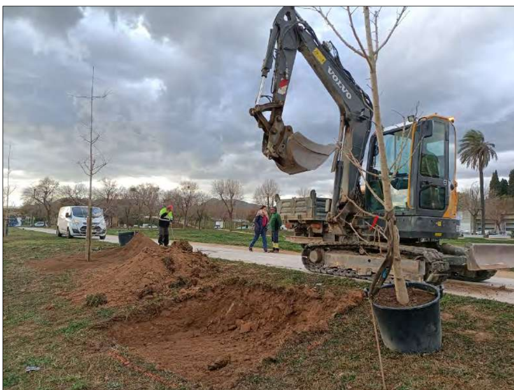
Sondeig 12; Fotografia del procés de rebaix.
