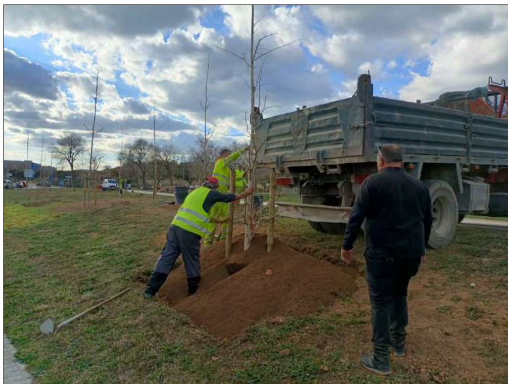
Sondeig 10, Fotografia dels treballs de col·locació de l'arbre.
