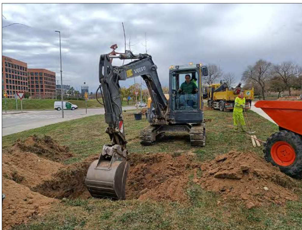
Sondeig 7; Procés de rebaix de setè sondeig.
