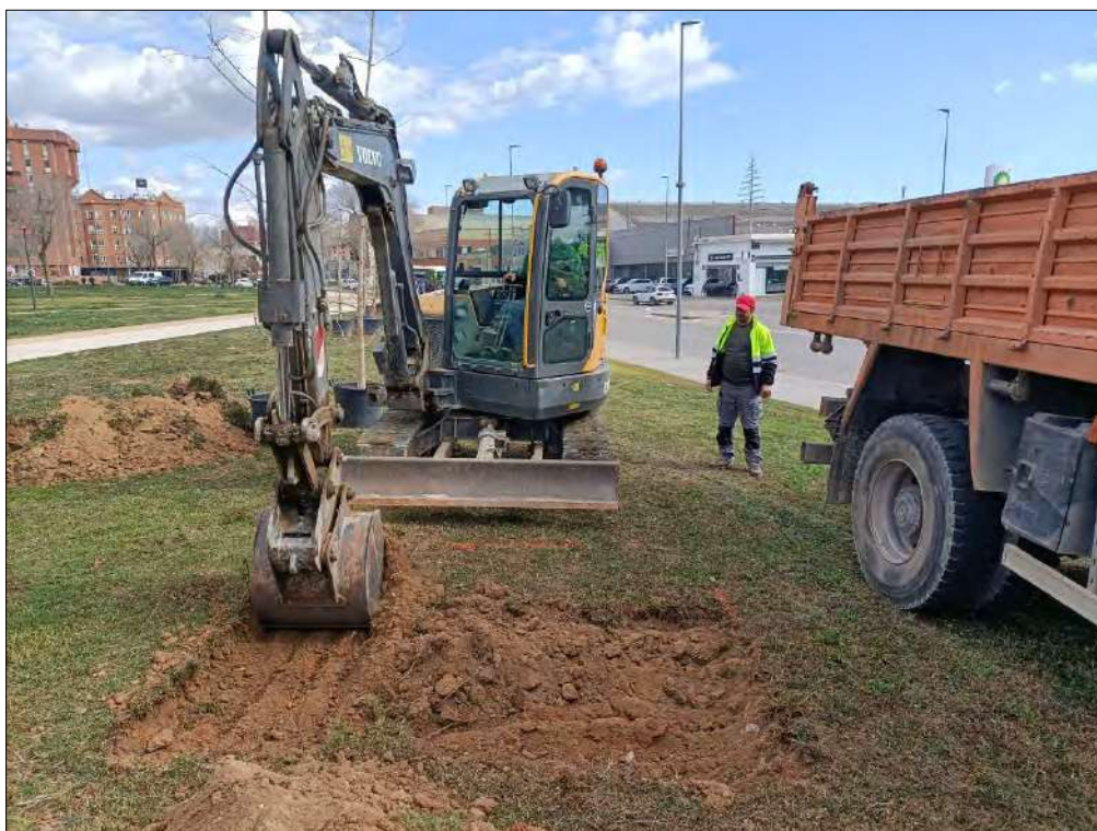
Sondeig ; Fotografia del procés del rebaix.
