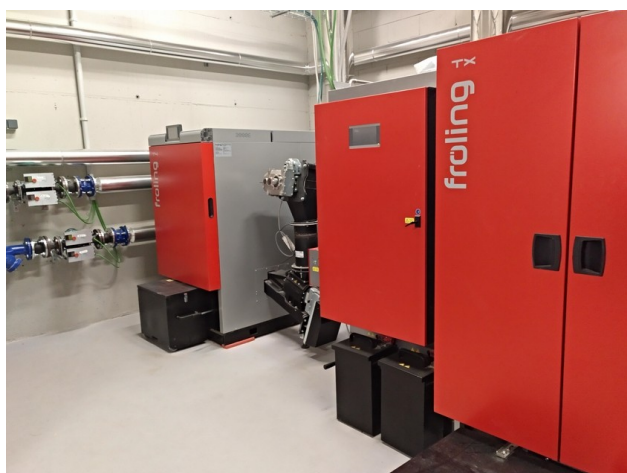
Imatges 1 i 2- Sala de calderes de Biomassa i Dipòsits d'inèrcia i circuit que va cap a l'Agulla
