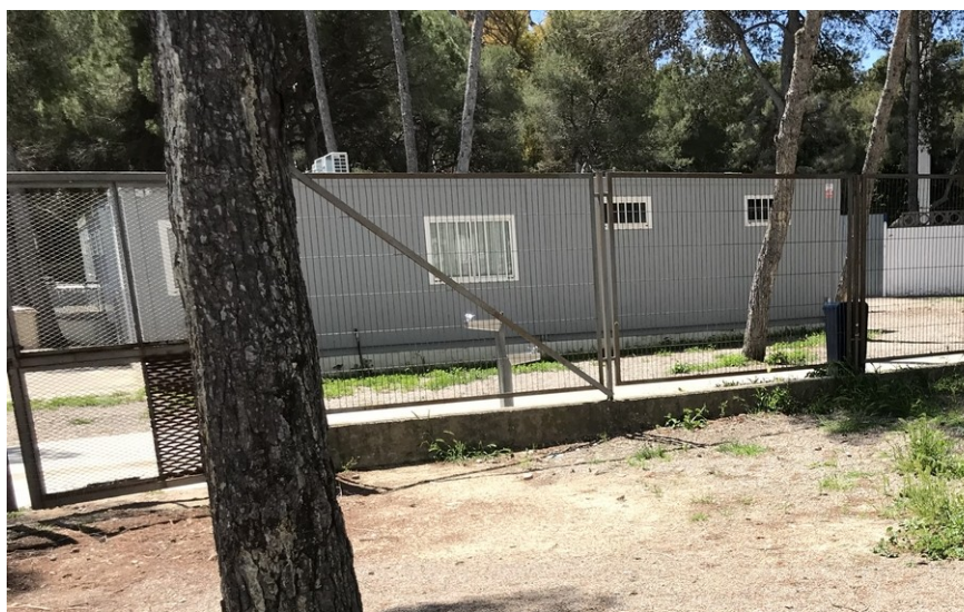
Imatge 8.- Exterior mòdul prefabricat oficines i magatzem
