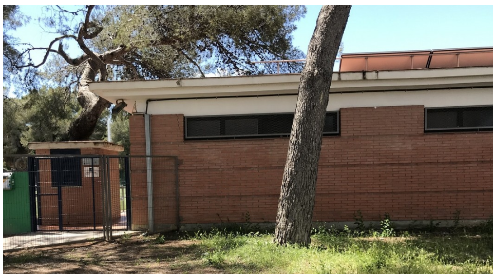
Imatge 6.- Exterior edifici Vestidors principal
