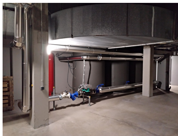
Imatges 1 i 2- Sala de calderes de Biomassa i Dipòsits d'inèrcia i circuit que va cap a l'Agulla
