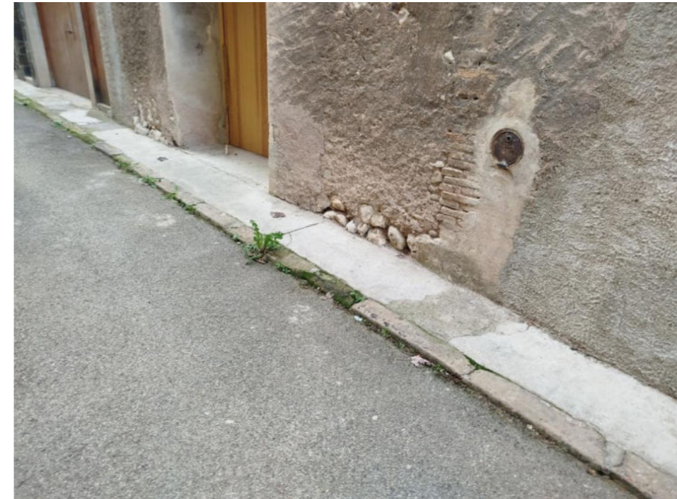
Figura 38: Detall escomesa en façana a les Coromines
