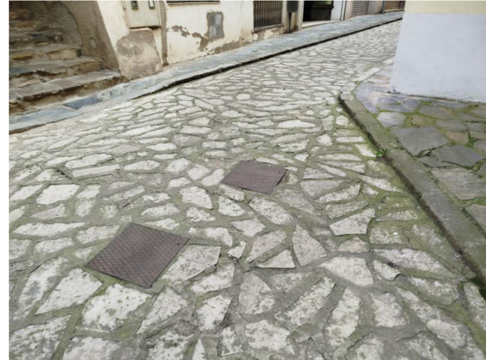
Figura 14: Detall paviment i arquetes C/ dels Porxos
