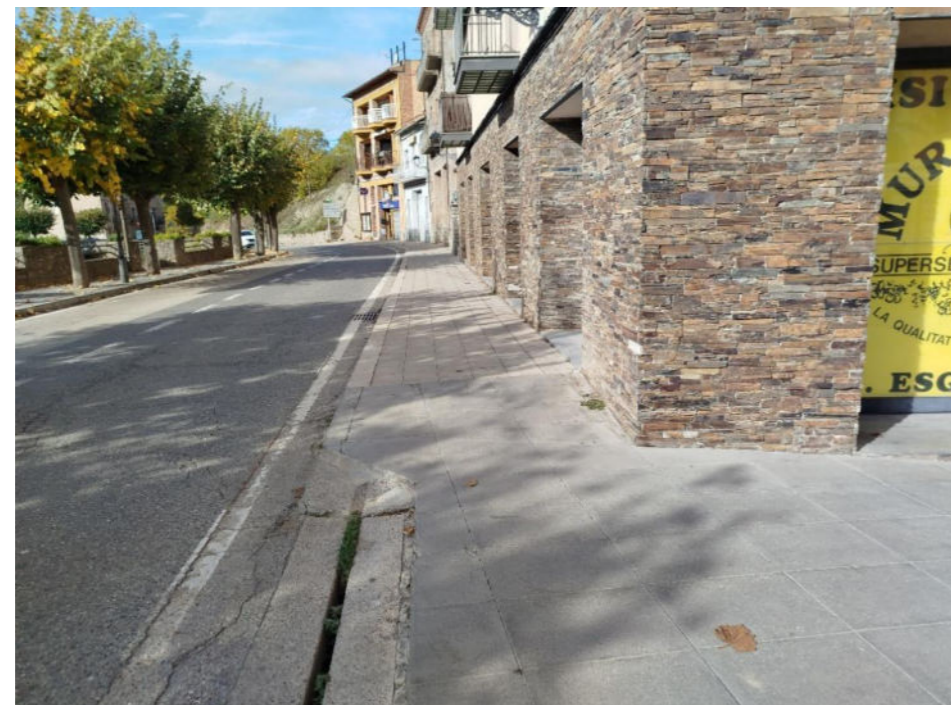
Figura 9: Cantonada C/ Jussà amb carretera de Ripoll
