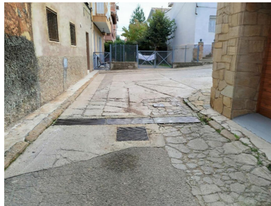
Figura 47: Cantonada C/ 8è de les Coromines
