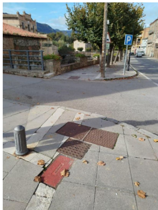
Figura 25: Detall arquetes i hidrant Plaça de l'Ajuntament
