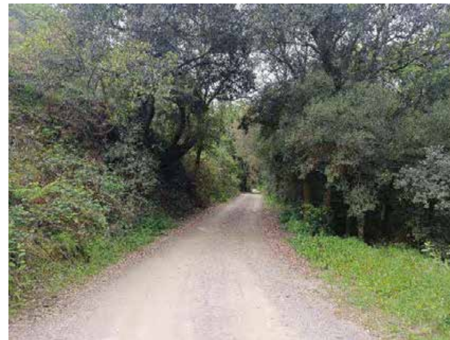
Fotografia 7. Camí rural d'accés al pont
