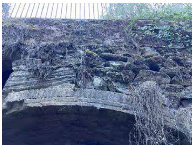
Fotografia 2. Estat general dels timpans del pont
