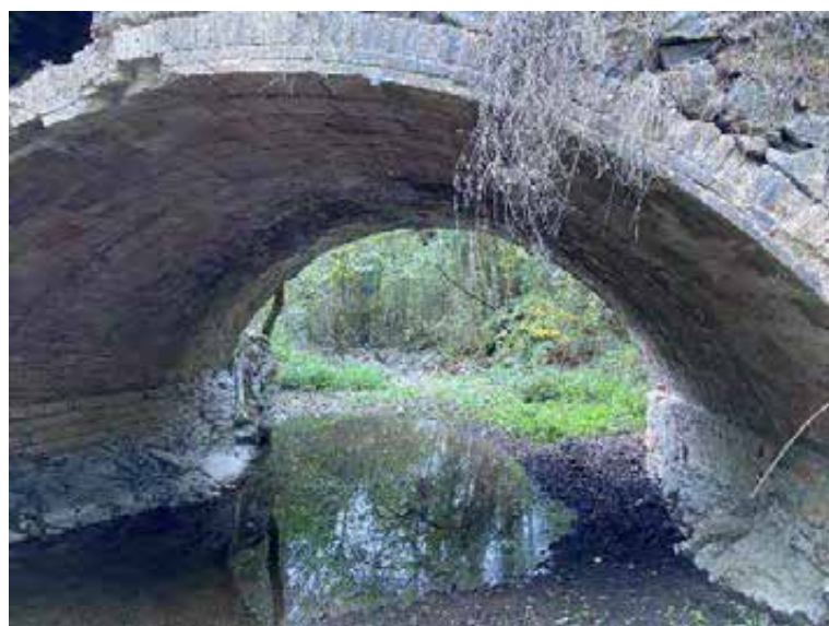
Fotografia 1. Vista interior de l'arc del pont existent
