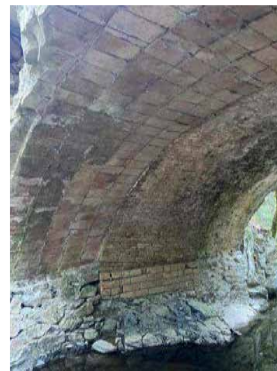
Fotografia 3. Detall de l'arc on s'evidencia l'ampliació anterior
