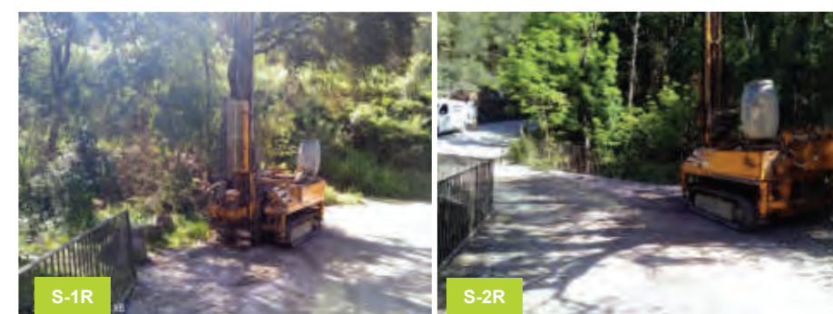
Figura 2. Emplaçament dels sondeigs a rotació.
