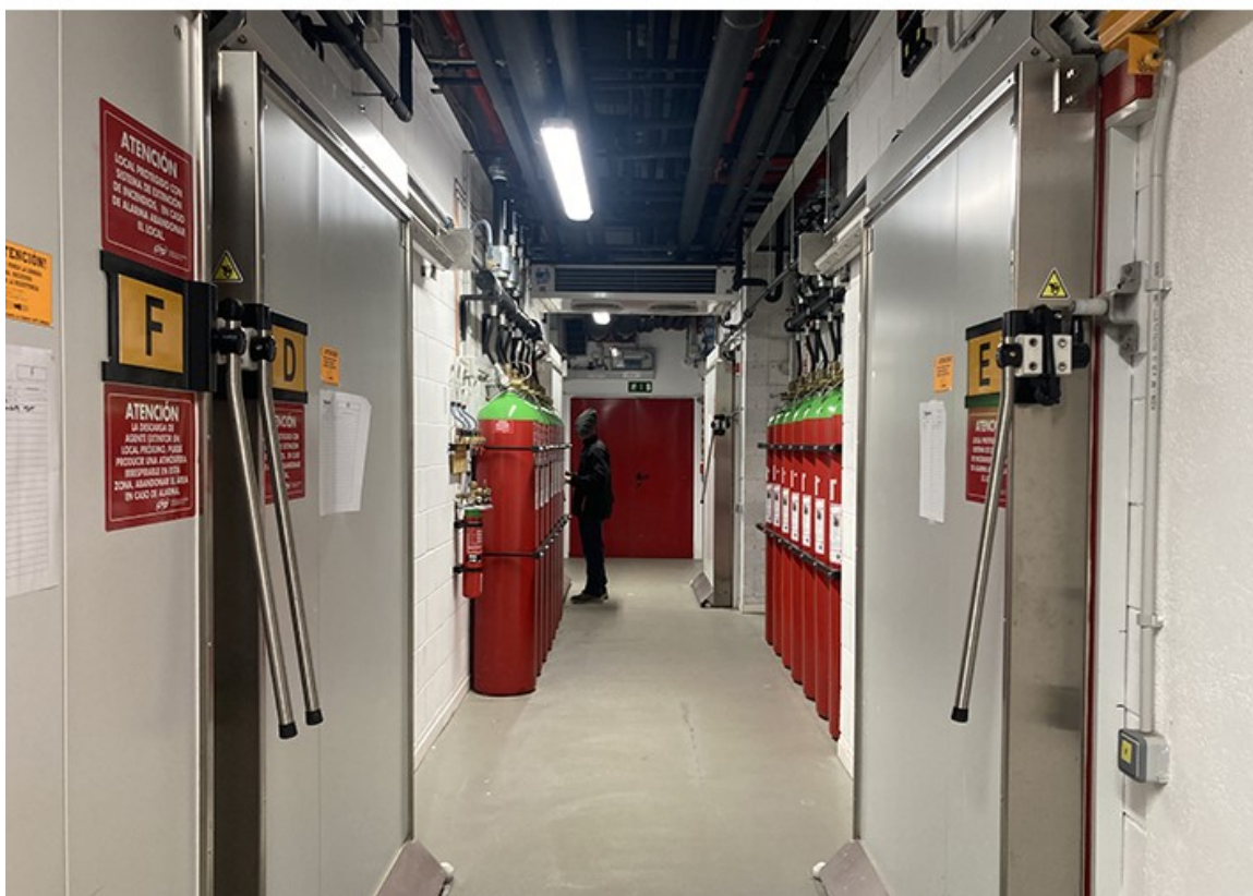
Fotografies del passadís central de la planta soterrani que dona accés als dipòsits existents
