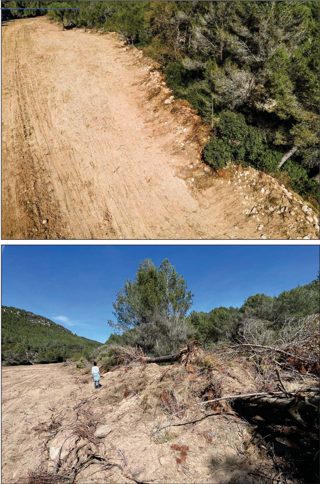
Figura 12. Imatges de la “mota” construïda amb les restes de material procedent del trencament de la parcel·la (terra, blocs, arbres i arbustos). Abril 2022
