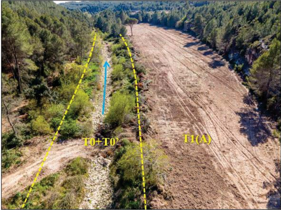
Figura 5. Estat actual de la terrassa o unitat morfo-funcional T1(A) (s'indica també l'espai lateral abastat pel conjunt de la llera activa (T0), i la llera d'aigües altes o bankfull (T0')).
