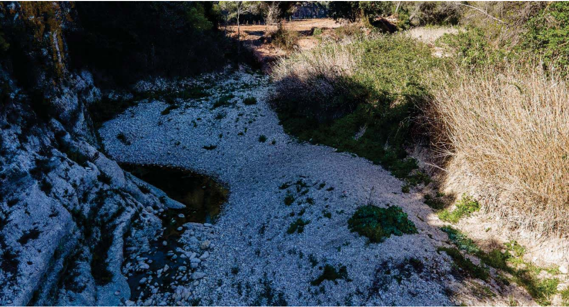
Figura C1. Dipòsit de material al·luvial (barres de graves) atrapat en el vas de l'assut de Mas Esplugues
