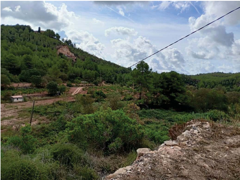
Fotografia 59. Tram de línia elèctrica a desviar (vista des de la masia)
