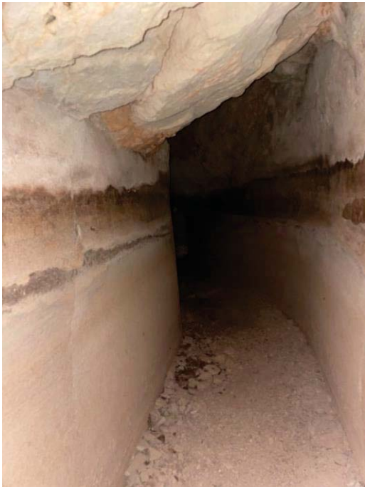
Fotografia 53. Detall secció canal de derivació (entrada en la mina)
