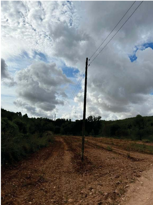
Fotografia 58. Primer suport de fusta que es substitueix per torre de formigó
