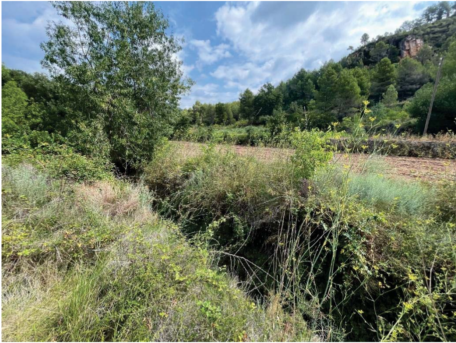
Fotografia 48. Perspectiva del canal de derivació
