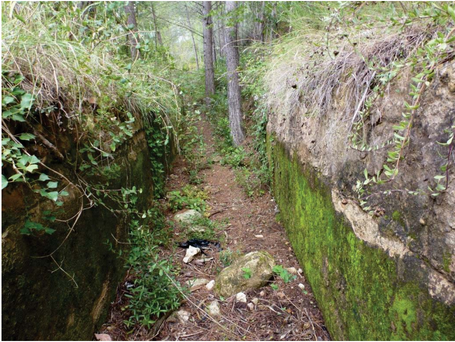
Fotografia 52. Detall secció canal de derivació
