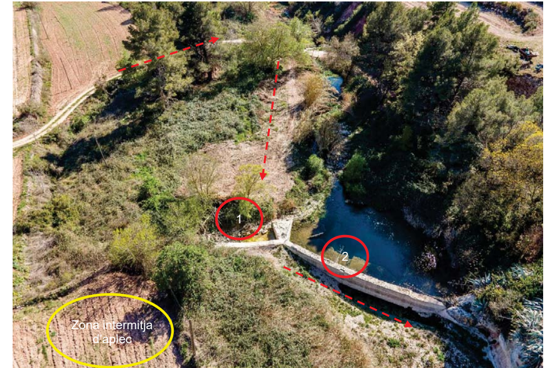
Figura 1. Logística de demolició de la resclosa
