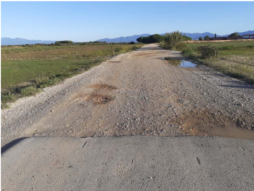
Punt aproximat 0+590. Vista des de la zona pavimentada del terme municipal de Riumors.
