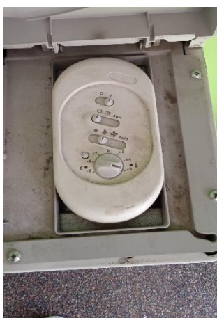
Figura 7. Sistema de control de recinte i de fancoil
