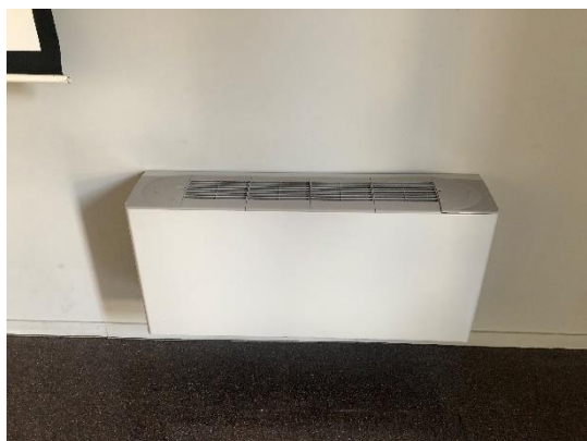
Figura 7. Exemple de fancoil existent i fancoil retirat
