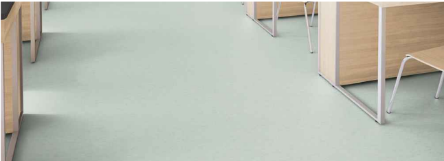
Ⓓ Paviment aules Linoleum
