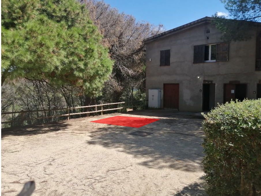
Vista general àmbit implantació mòdul
