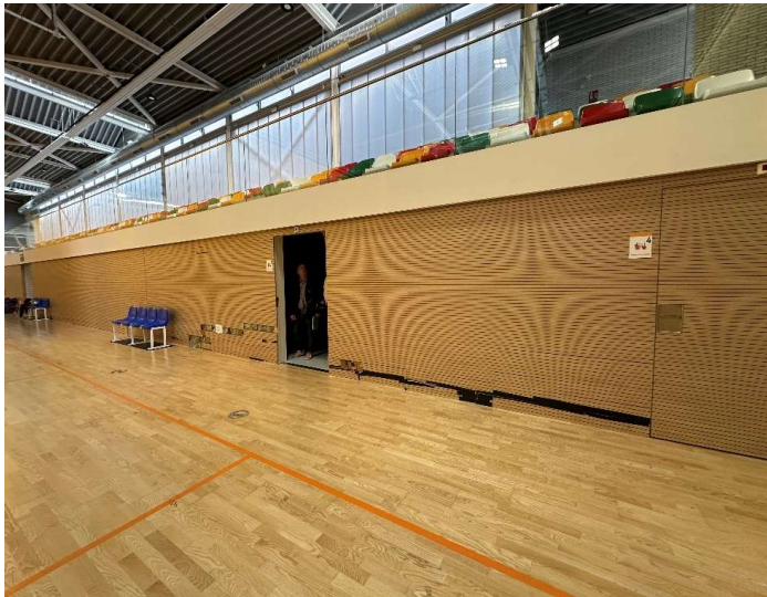
IMATGE GENERAL. ESTAT ACTUAL DEL REVESTIMENT I PORTES
