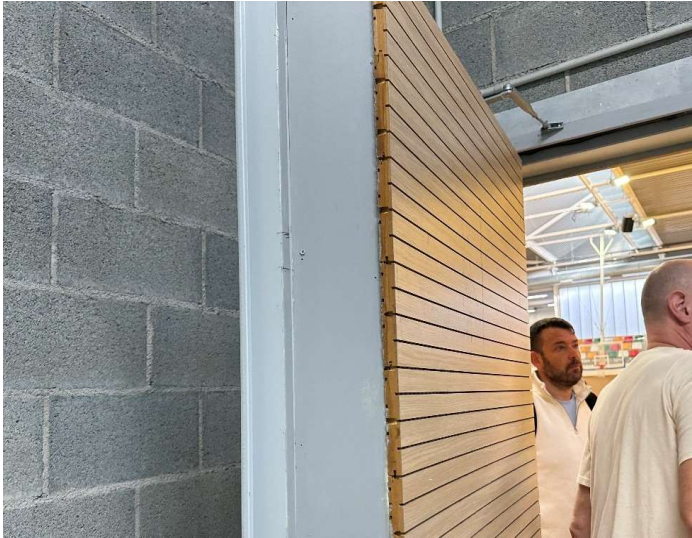
DETALLI REVESTIMENT EN PORTA RF.
