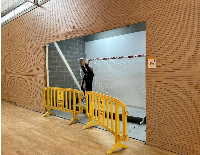
ESTAT ACTUAL. OBERTURA RESULTANT DESPRÉS DE TRENCAMENT I RETIR DE PORTES DE FUSTA DE 4 FULLES.
