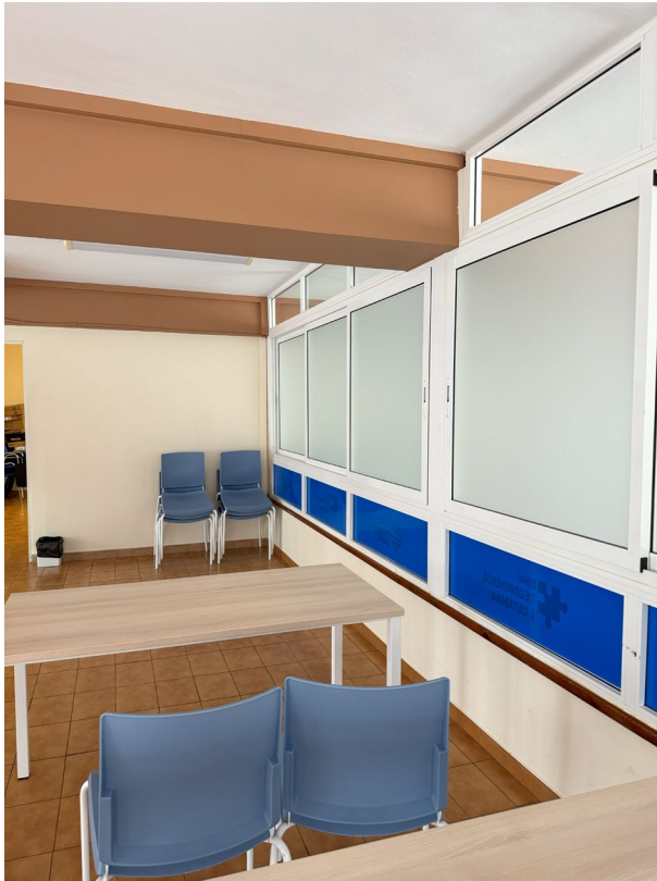
Foto 6: Interior d'aula. Autor: ROA Arquitectura
