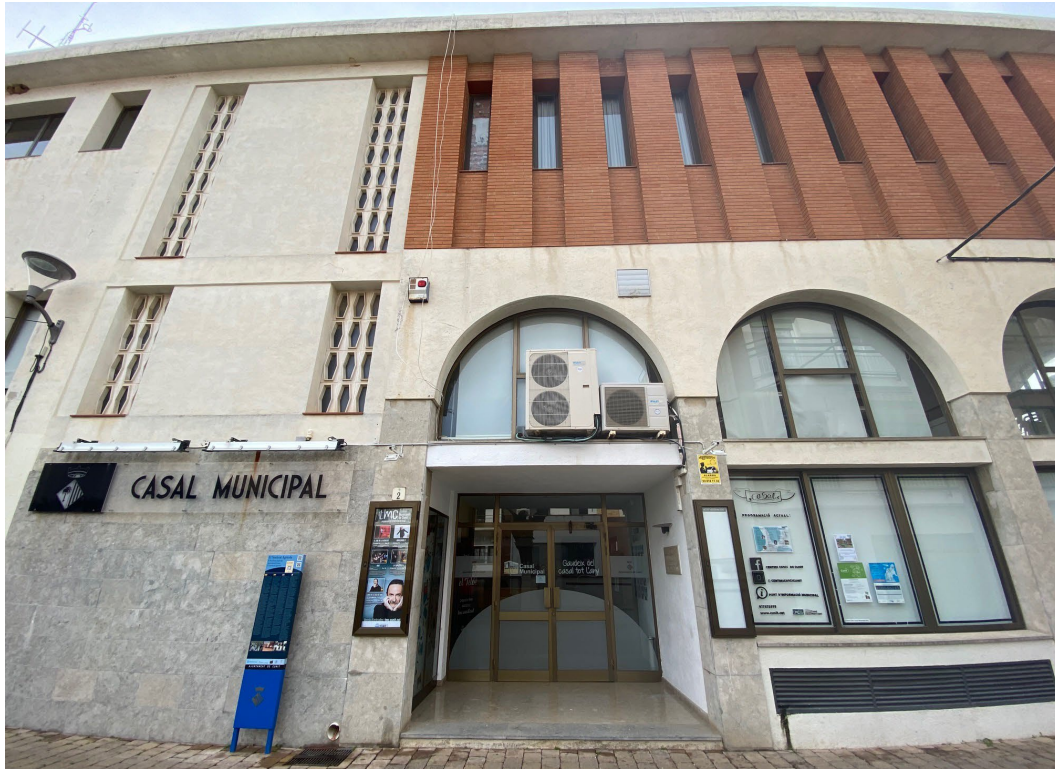
Foto 5: Façana oest, carrer de Sant Joan. Autor: ROA Arquitectura
