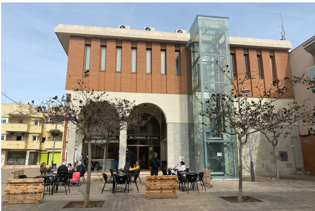
Foto 4: Façana est. Autor: ROA Arquitectura
