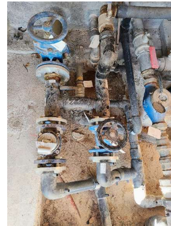
Figura 2. Dipòsit Galera - interior caseta de bombes est
