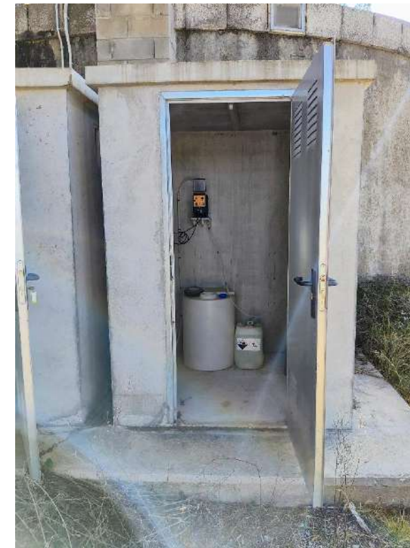
Figura 10. Dipòsit Granges - zona d'emmagatzematge de químics per a cloració
