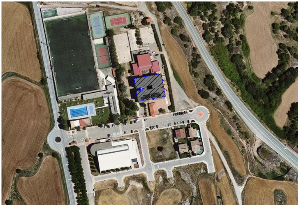
Fig 2. Ubicació del edifici públic on s'ubica l'Escola Lluçanès
