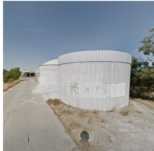
Figura 4. Dipòsits d'aigua. PK0+863.
