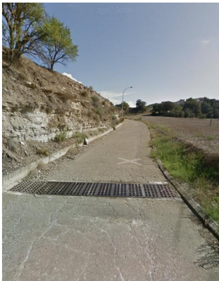
Figura 3. PK0+137. Connexió amb la reixa.
