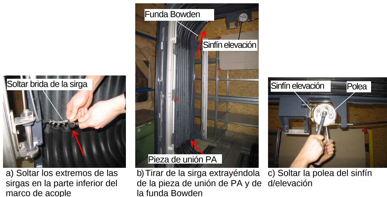
Figura 29: Sustitución de las poleas y sirgas metálicas (esquemático)
