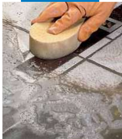
Acabado de pavimento cerámico con inserciones de madera, con esponja
