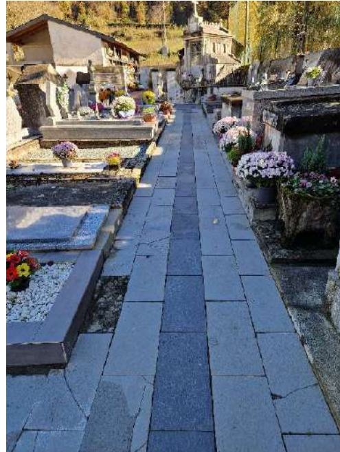
Imatge 5. Els carrers més obacs presenten les pitjors condicions: major número d'esquerdes, diferència de nivells i lloses que falten.
