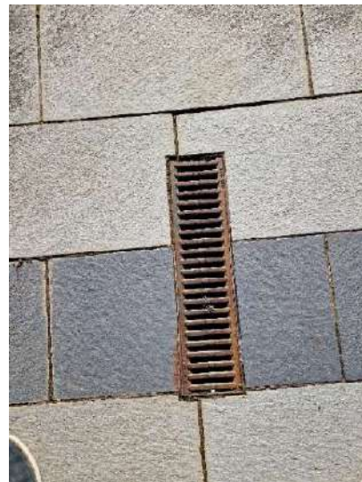
Imatge 7. Les reixes de drenatge, tot i presentar signes de corrosió, es troben en bon estat i no representen cap perill. .
