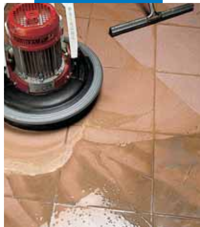
Acabado de pavimento porcelánico con máquina monodisco y regleta de goma
