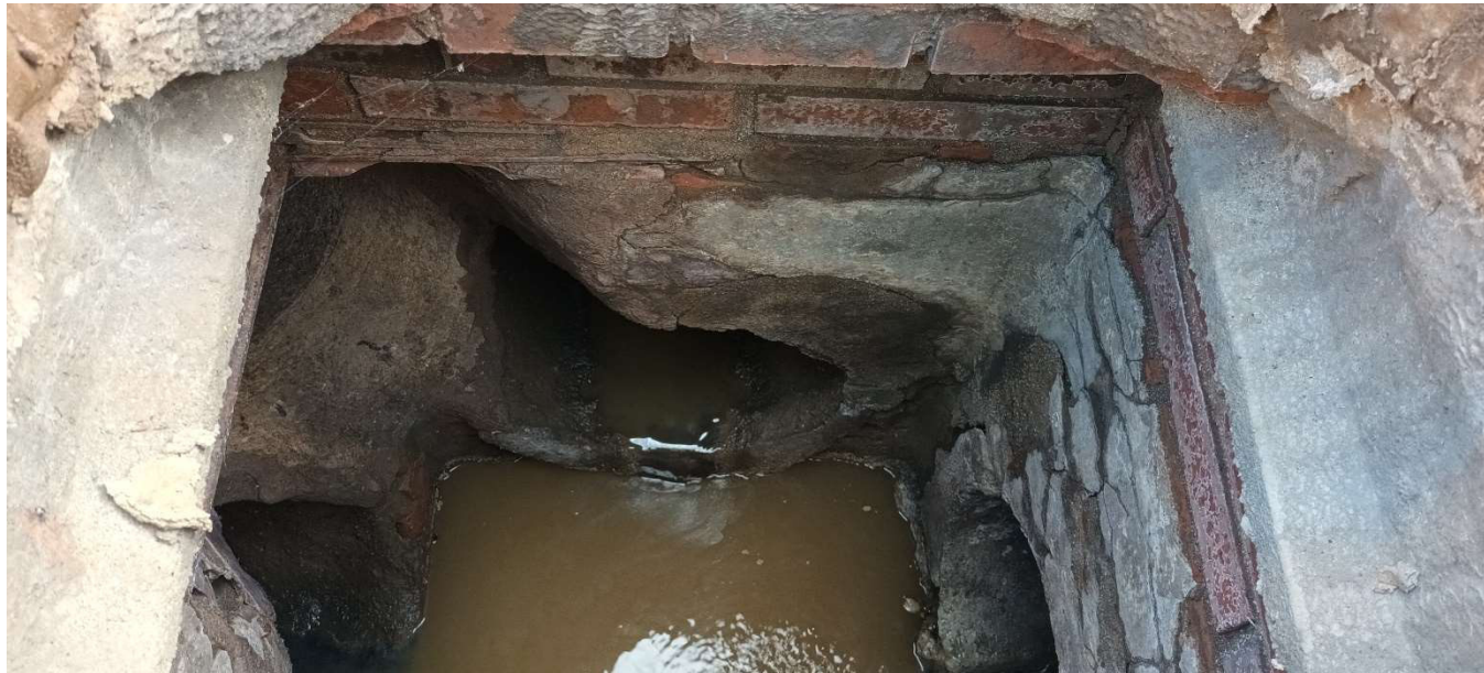
Imatge 5 -Visita de l'interior del pou 3, fi de l'actuació. Frontalment es pot veure el col·lector a substituir, a la dreta el col·lector d'arribada del carrer Collsacabra i a l'esquerra el col·lector de sortida. Els tres de formigó.
