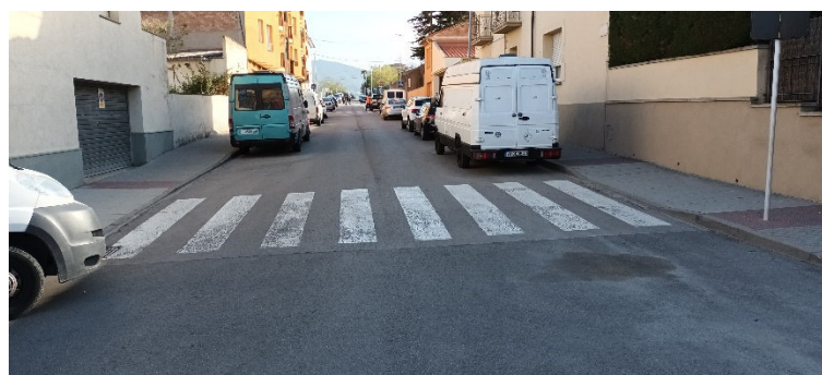
Figura 2. Imatge del tram del carrer Puigdassalit, des del pou P3.
