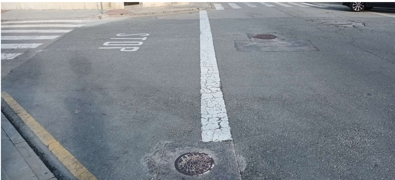
Imatge 2- Visita de la intersecció del carrer Puigdassalit amb el carrer Damians, on es pot veure el pou 1, inici de l'actuació.
