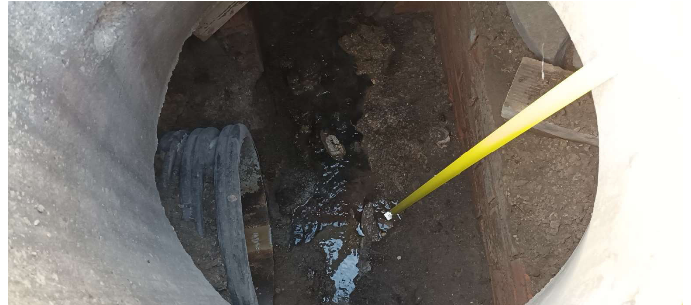
Imatge 3- Visita interior del pou 1, a l'esquerra el col·lector d'entrada provinent del carrer Damians.
