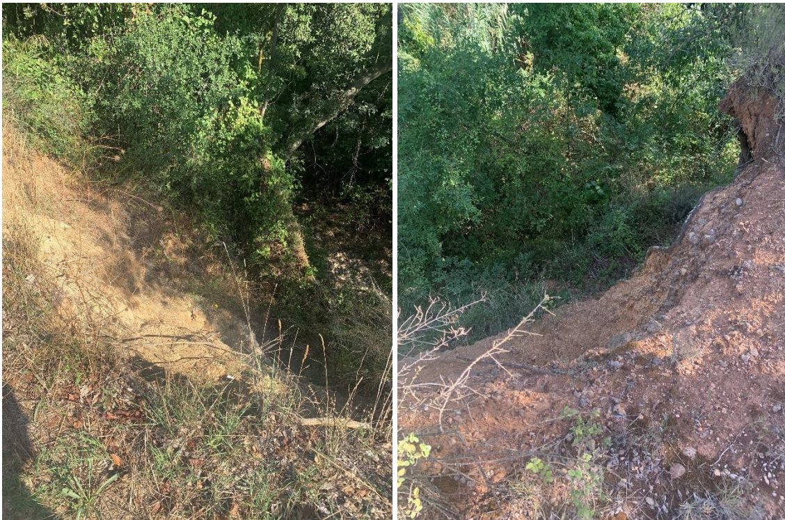
Figura 2. Estat actual de l'esllavissada al camí de Vilanant a Lladó
