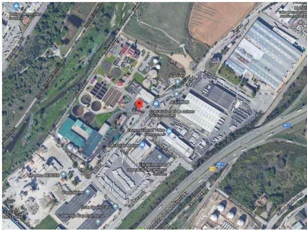
Figura 1. Vista aèria del CCTRVO. Font: Google Maps 2019.
