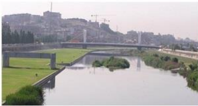
Diferencias entre el margen derecho (no uso público) y margen izquierdo, de uso público y con márgenes abruptos y artificiales
