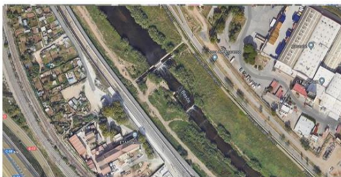
Imagen de zona 3. Espacio de la balsa de nueva creación
