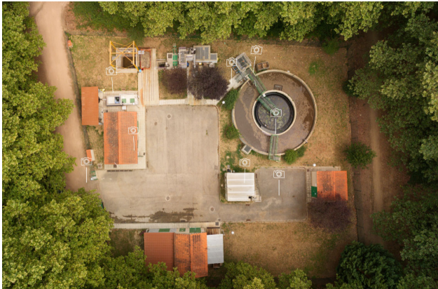
Figura 1. Vista aèria de l'EDAR Vallgorguina.
