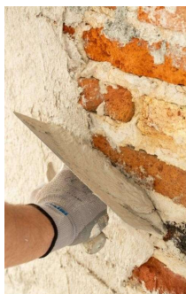
Aplicación del mortero
