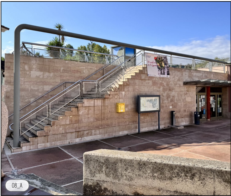
08_NETEJA I CONSOLIDACIÓ D'APLACAT DE PEDRA AMB AIGUA A PRESSIÓ I APLICACIÓ DE CONSOLIDANT 8020 DE MAPEI
