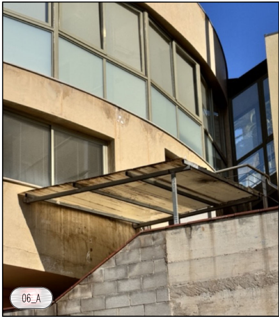
06_DESMUNTATGE DE COBERTA DE POLICARBONAT I MUNTATGE DE NOU COBERT DE MIDES I CARACTERÍSTIQUES SIMILARS
