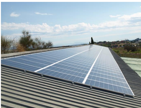
Instal·lació coplanar a coberta de xapa
