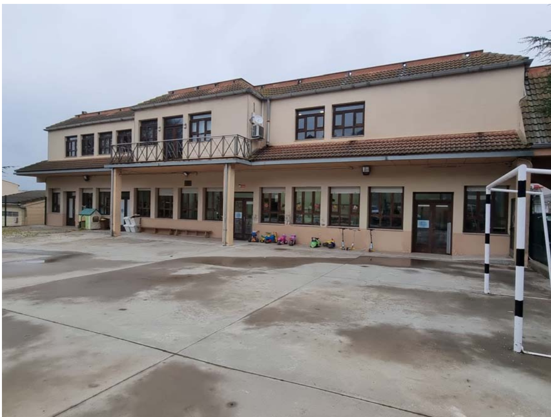
Estat actual de la façana principal SUD
