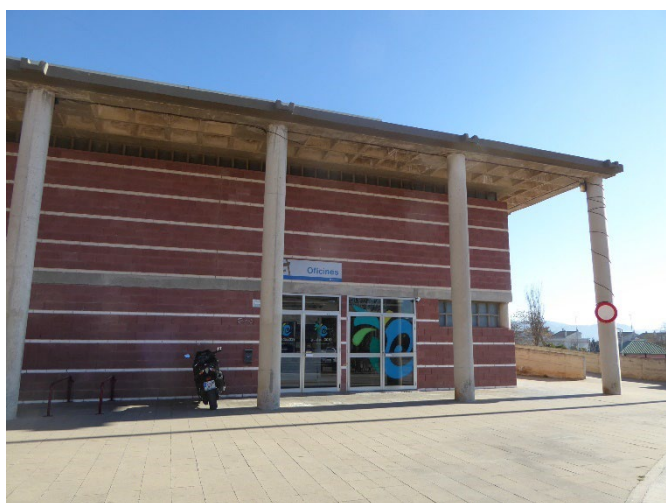
Vista general del edificio oficinas. Fachada oeste
