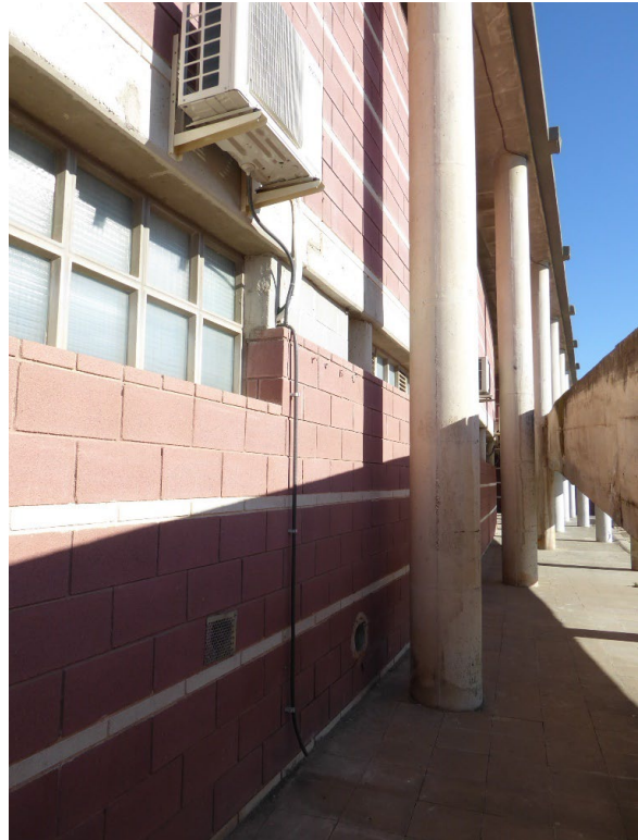
Vista general del edificio oficinas. Fachada sur-este
