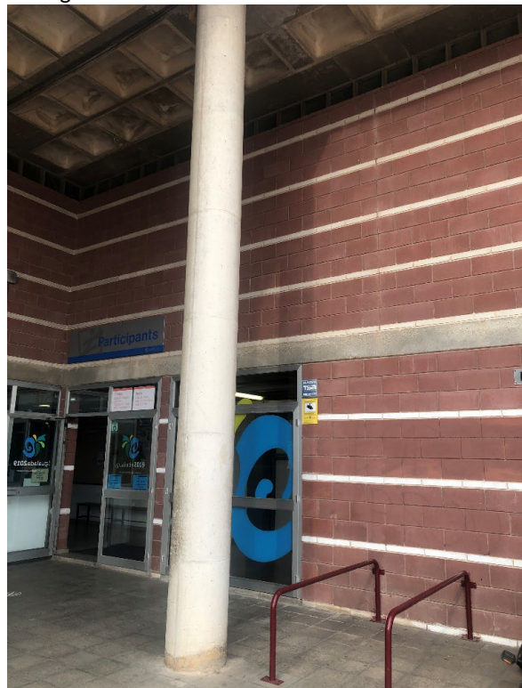
Detalle zona límite de ejecución SATE.
