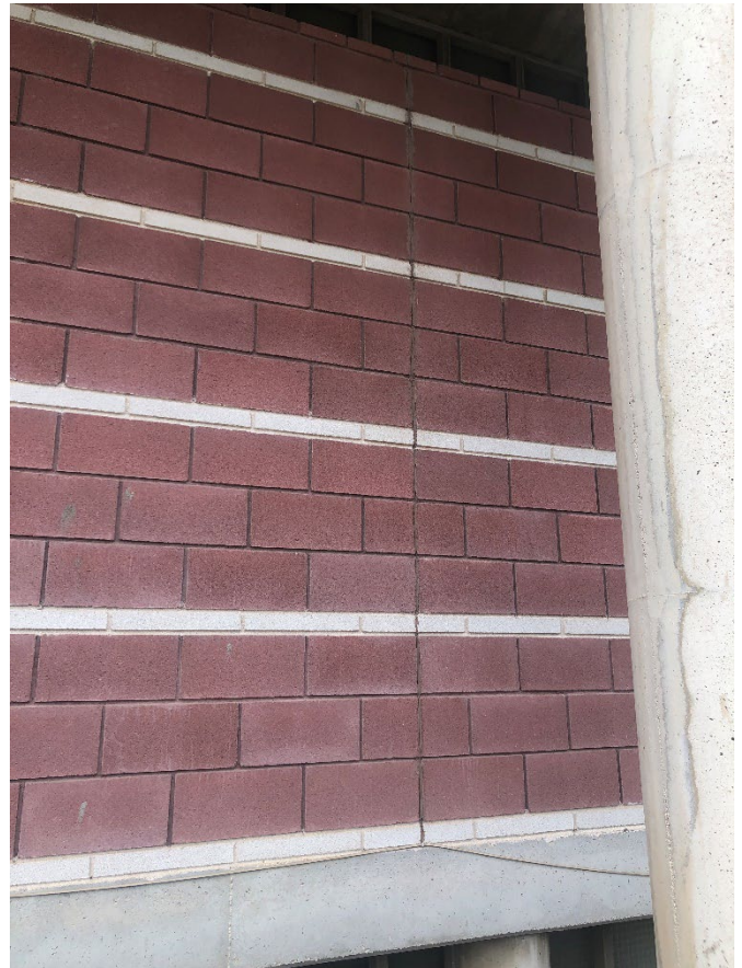
Detalle juntas estructurales-constructivas
