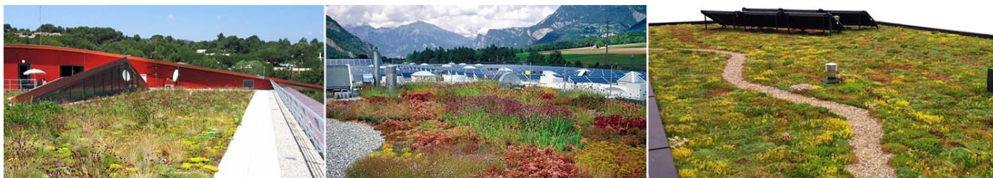
Imatge 7. Exemples de cobertes enjardinades extensives transitables.
