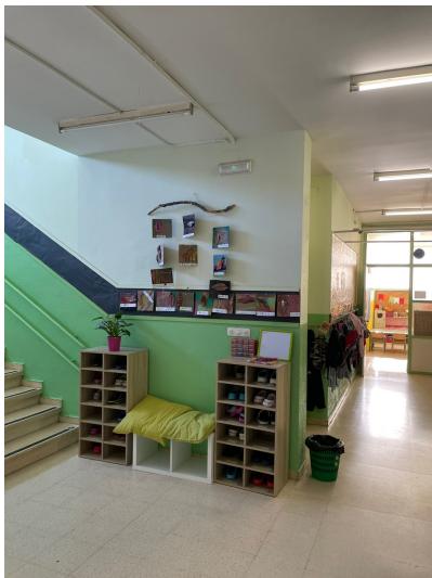
Enderroc envà accés ascensor PI-1
