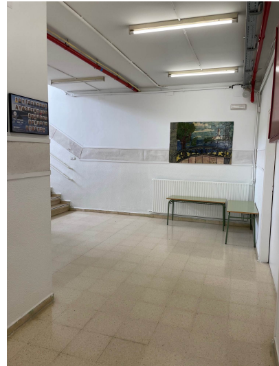
Enderroc envà accés ascensor PI-Baixa
