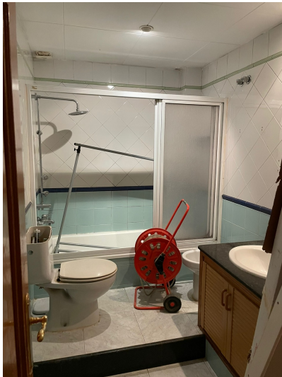
Arrancada mobiliari i instal·lacions CH
