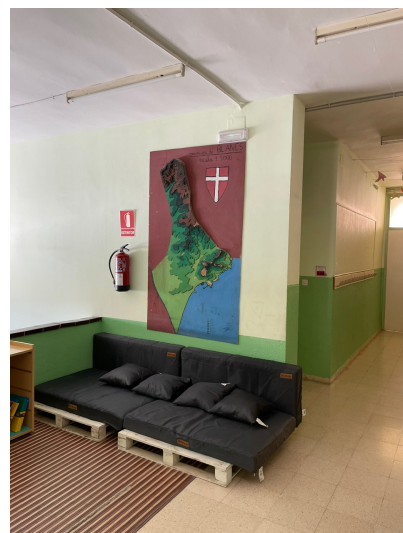
Enderroc envà accés ascensor PI-2
