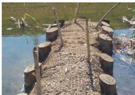
Exemple i secció tipus de palissada de troca d'arbustives
