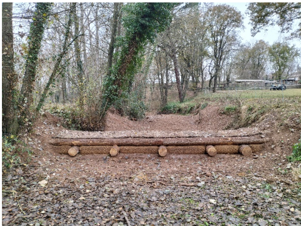
Figura 24 Dic entramat executat per Naturalea
