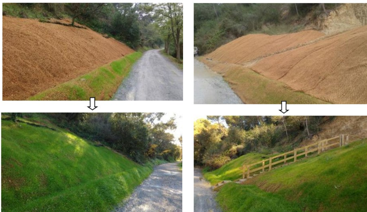
Figura 26. Ret de coco acabada de posar i amb la sembra ja desenvolupada
