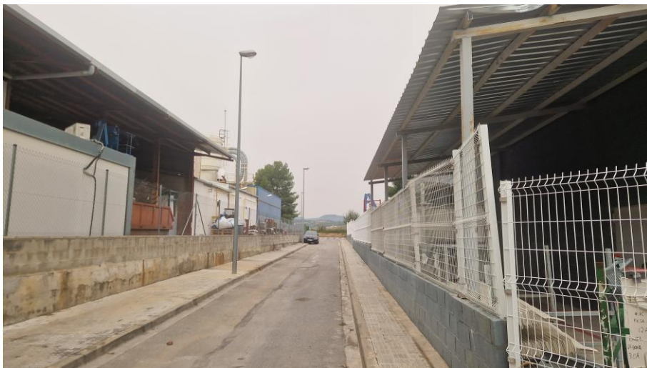
Vista de un dels carrers on les luminaries no son LEDs
