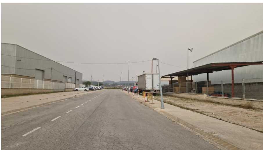
Fotografia de la columna que cal substituir
