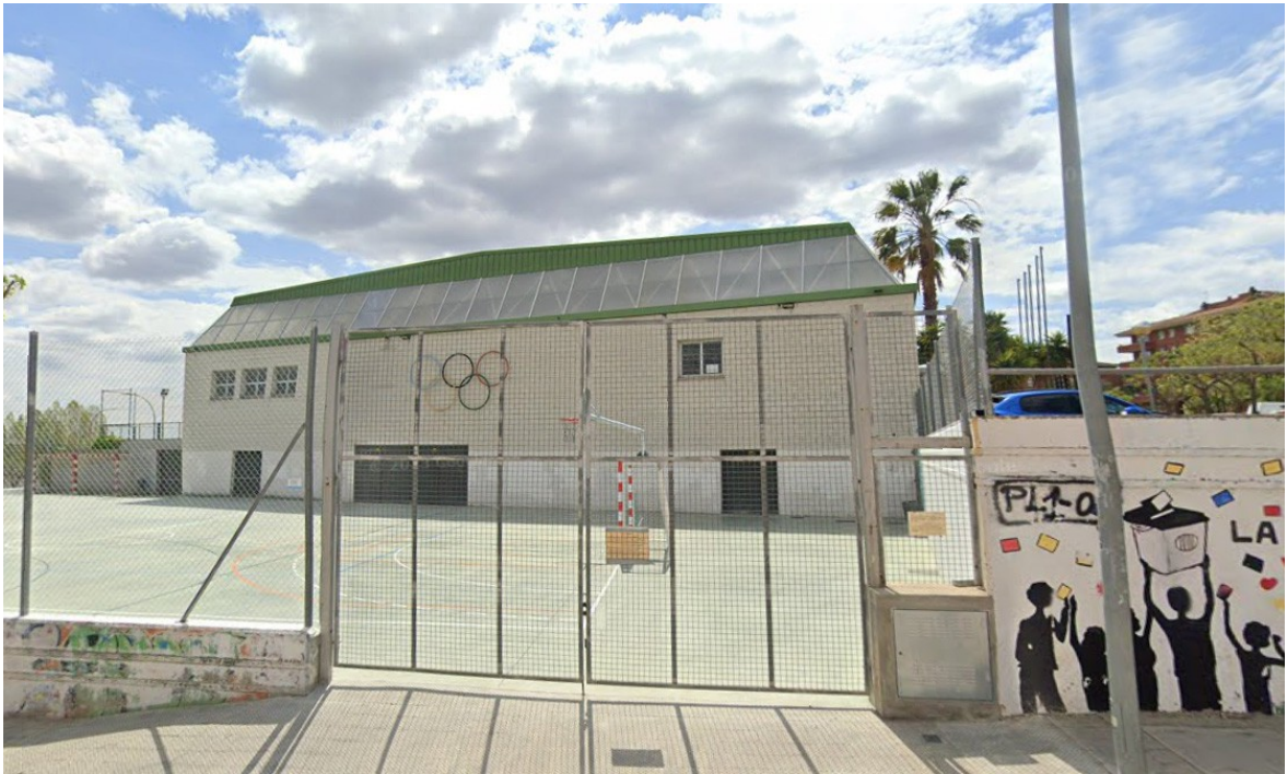
Vista de la façana nord de l'edifici on s'aprecia la darrera encavallada inclinada i el pendent de la coberta.
