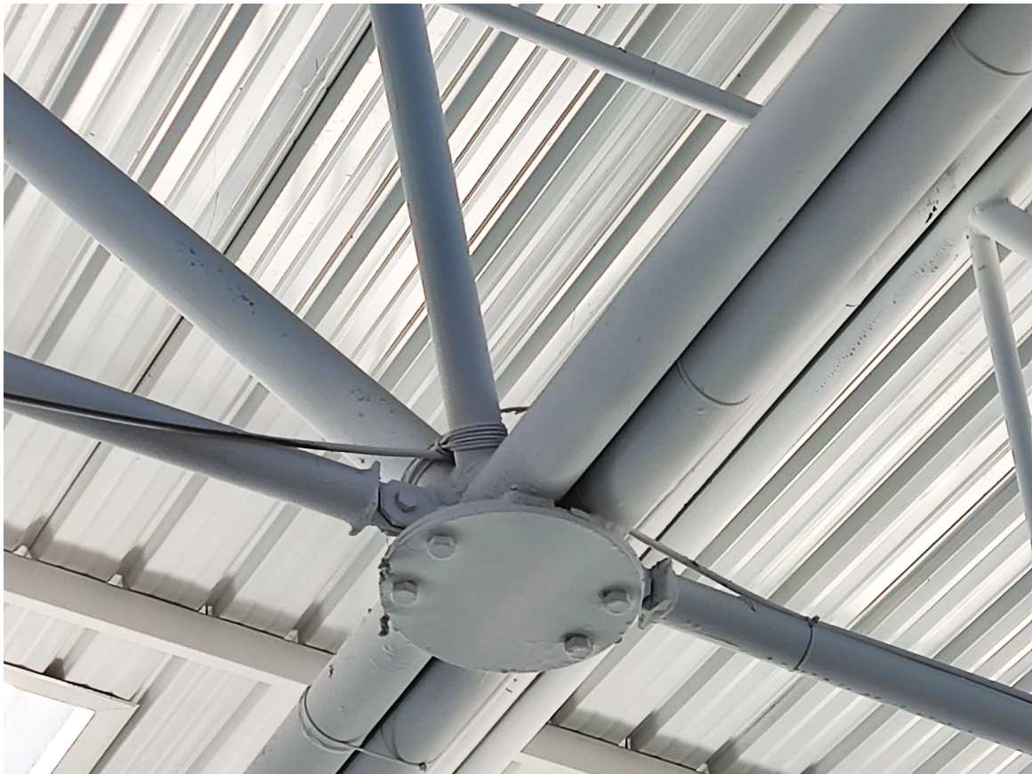
Vista d'un dels plats d'unió on van soldats els tubs i platines per connexió amb cargols.
