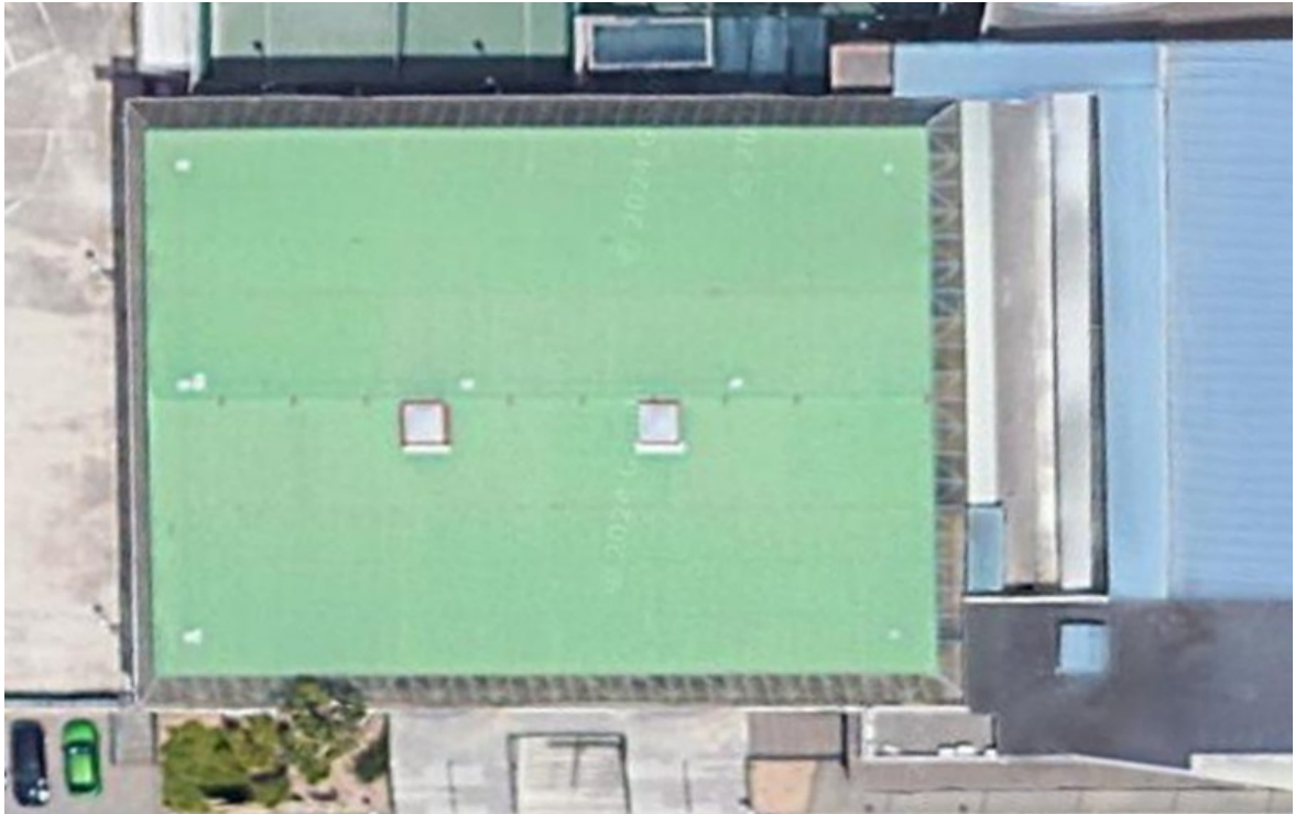
Vista aèria de la coberta del Pavelló Municipal d'Esports.
