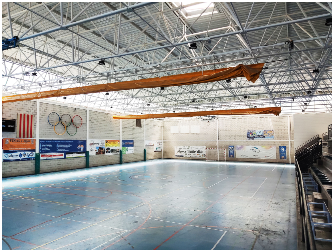
Vista de la pista del Pavelló Municipal d'Esports sota l'estructura de coberta.
