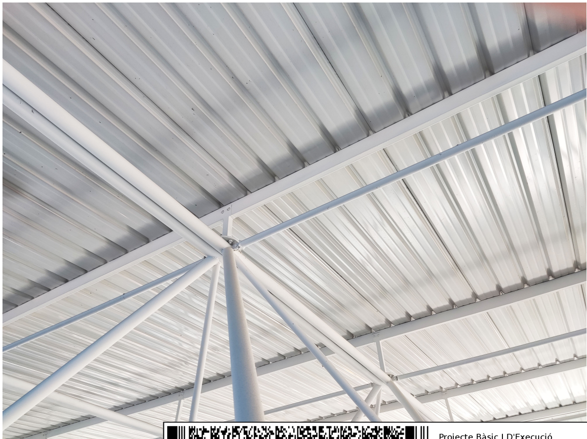
Vista de la subestructura
