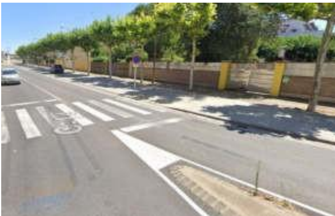
FOTO 13 – Col·locació de pilones per evitar aturades i infraccions
