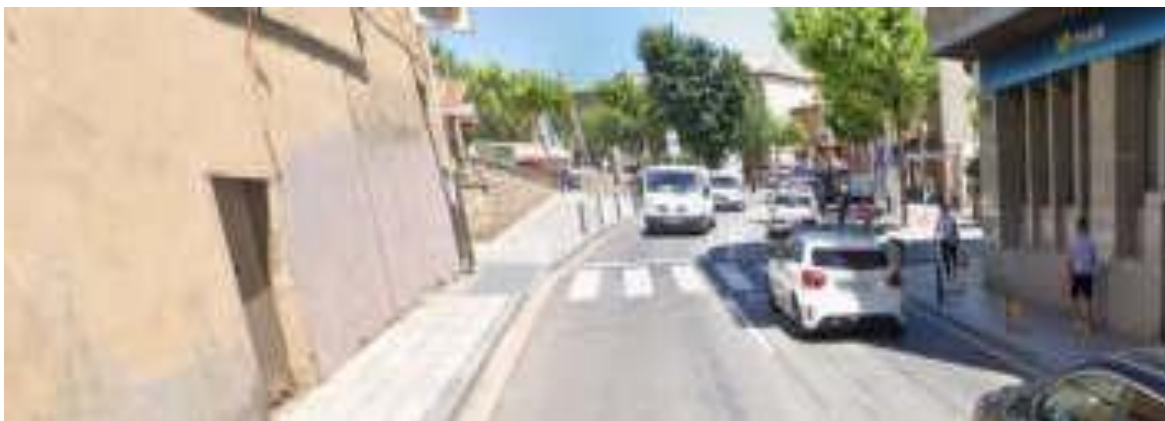
FOTO 11 – Instal·lació de senyals de pas de vianants amb llum i 4 balises
