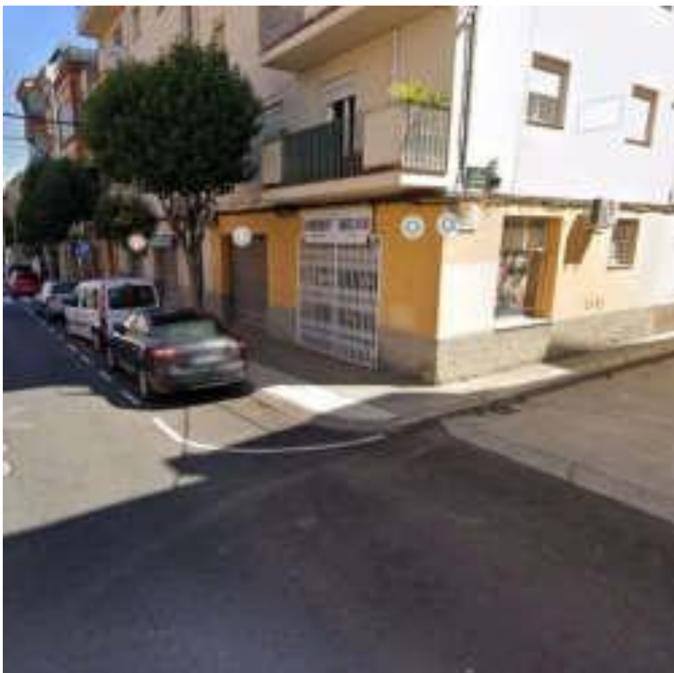
FOTO 3 – Construcció de rampa accessible
