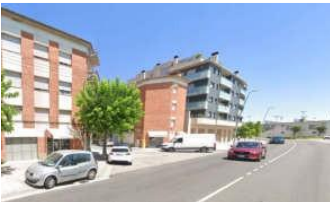
FOTO 12 – Ampliació de voreres per evitar aparcament als xamfrans
