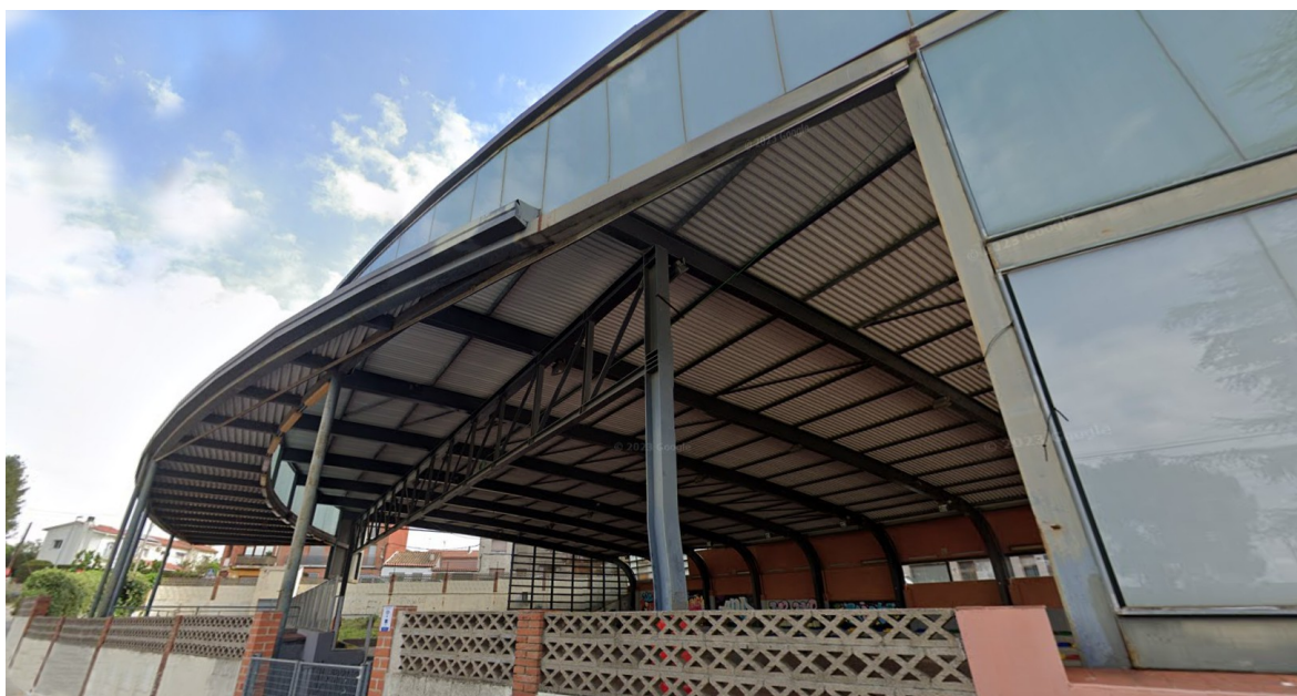
Vista del costat oest amb la marquesina i l'encavallada
