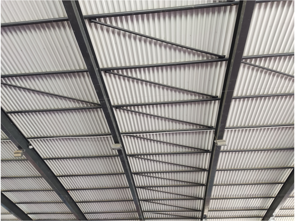
Vista zenital de la part central de la coberta.
