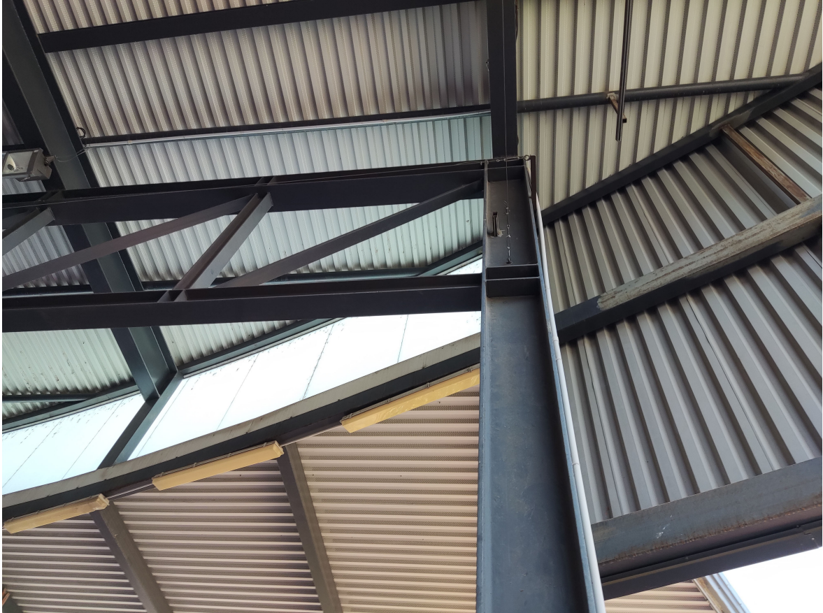
Vista de l'extrem nord de l'encavallada.
