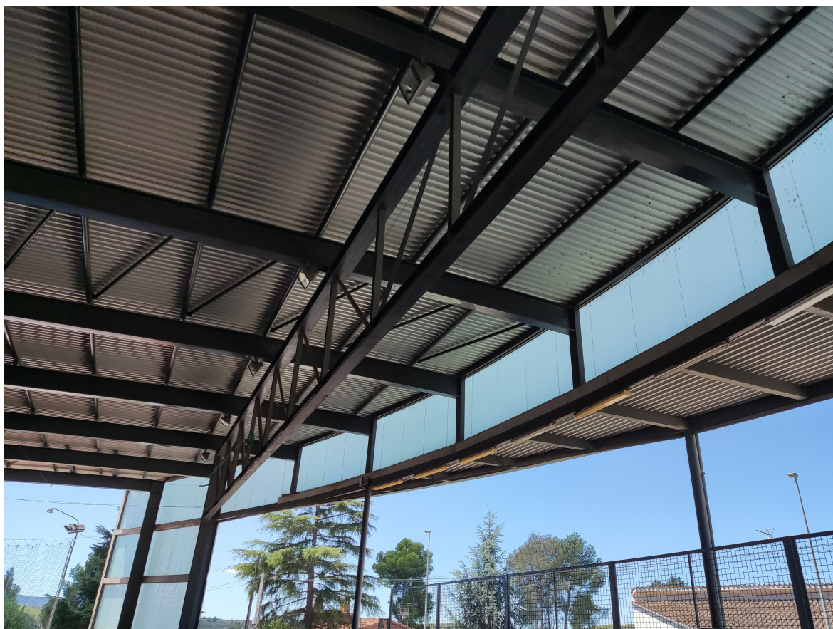
Vista de l'encavallada, de l'extrem oest dels pòrtics, de les diagonals horitzontals, de les corretges i dels panells de coberta.
