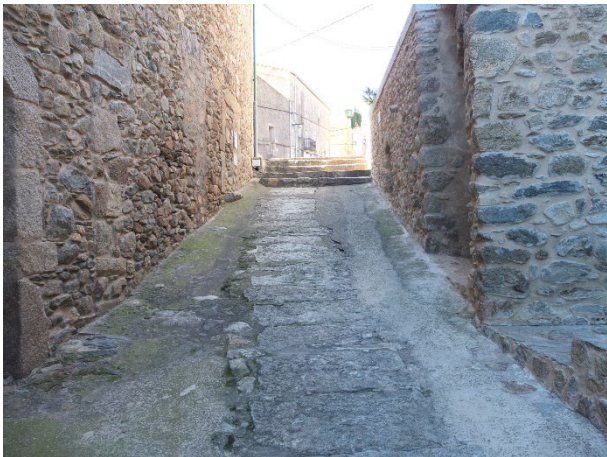
Figura 15 Inici àmbit des del carrer Orient
