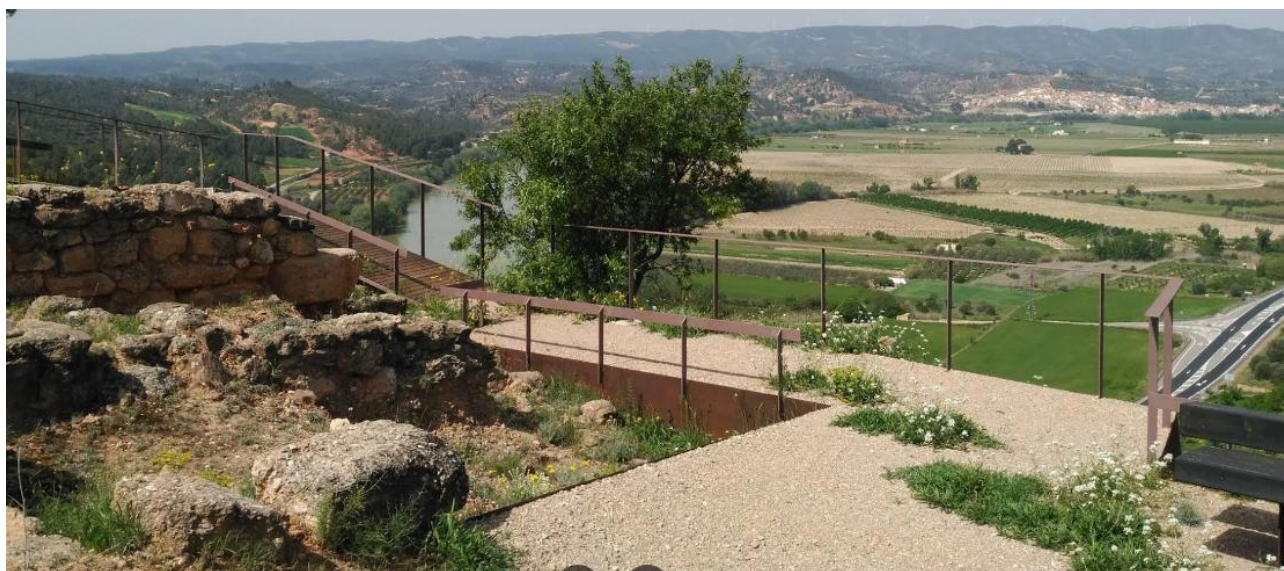
Exemple de barana composta per pilar i passamans sense tancament (Sant Miquel, Vinebre)
