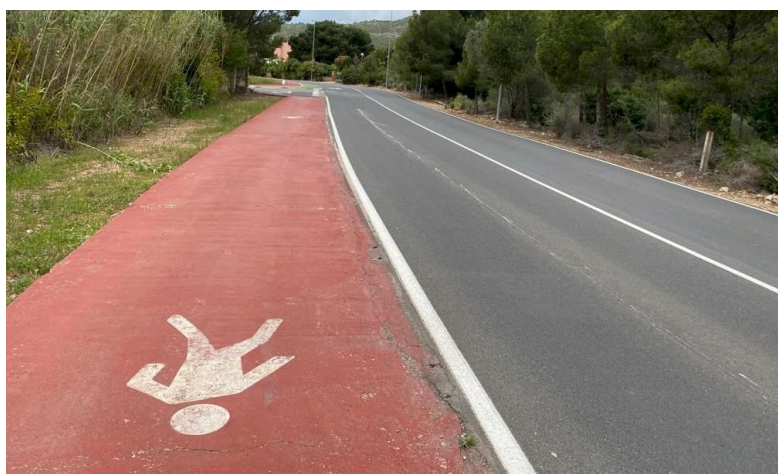
Arcén de vianants a Alcossebre (Castelló)
