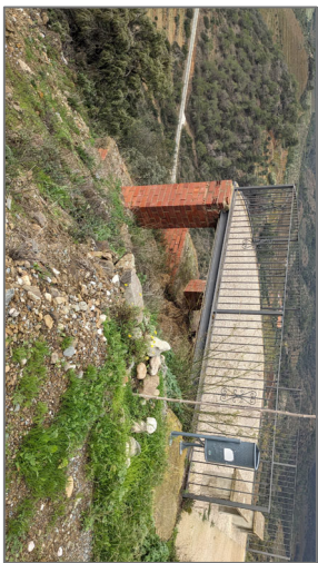
Mirador adaptat a l'estructura existent. Per a evitar elevacions excessives es construeix un paviment de taules de fusta de 35 mm de gruix
