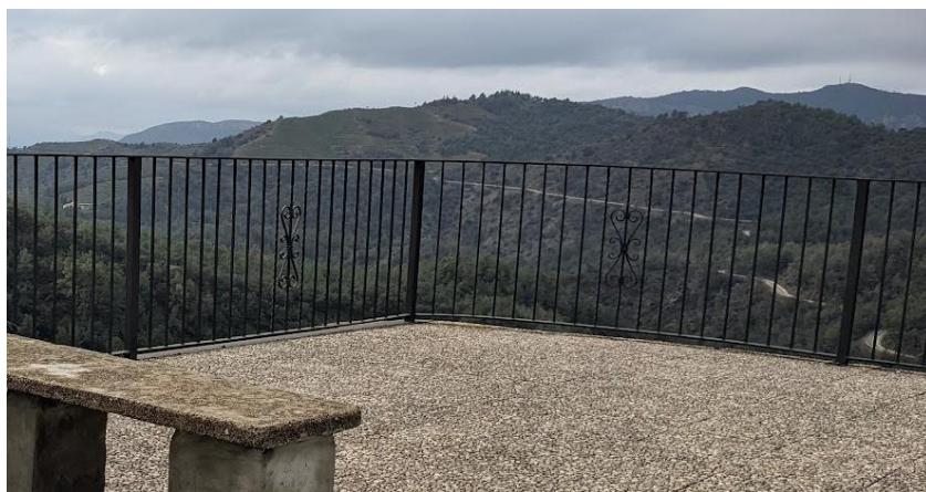
Barana existent al mirador de Torroja
