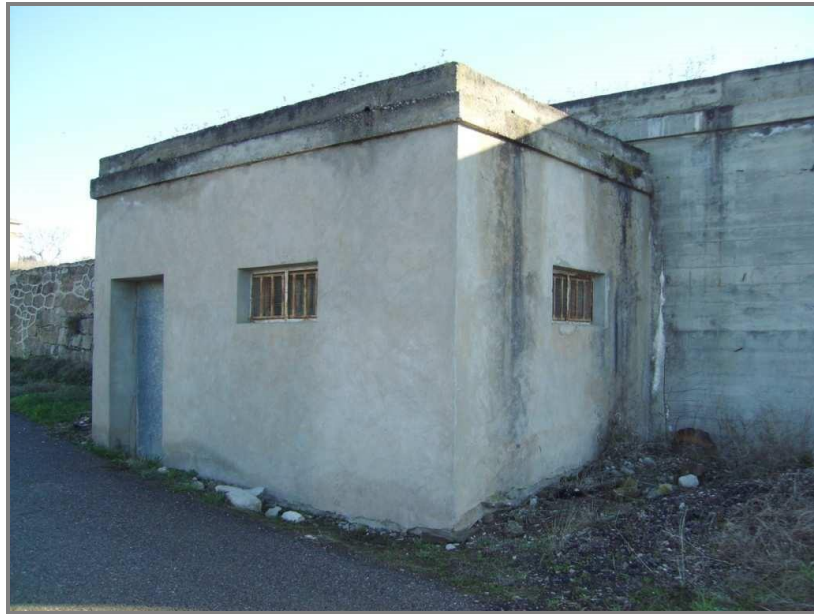
FIG 6. Caseta adossada al dipòsit quadrat.
