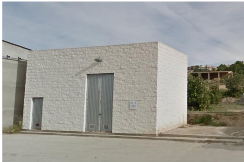
FIG 7. Estació de Tractament d'Aigua Potable.
