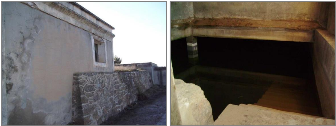
FIG 8. Vista general del dipòsit vell de Bellmunt d'Urgell i detall de l'accés al seu interior.
