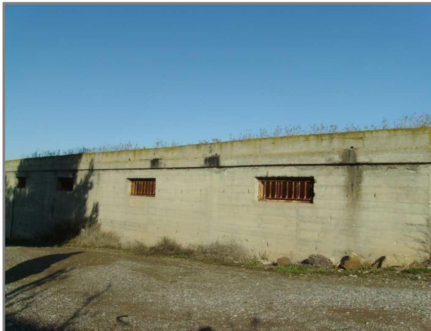
FIG 5. Vista general del dipòsit quadrat de Bellmunt d'Urgell
