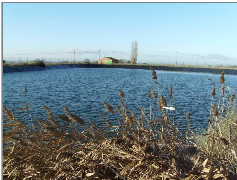
FIG 4. Vista general de la bassa de reserva en terres de Bellmunt d'Urgell
