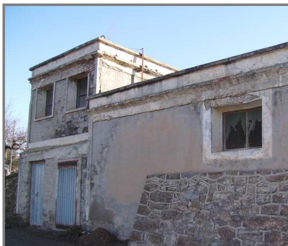
FIG 9. Caseta adossada al dipòsit vell.
