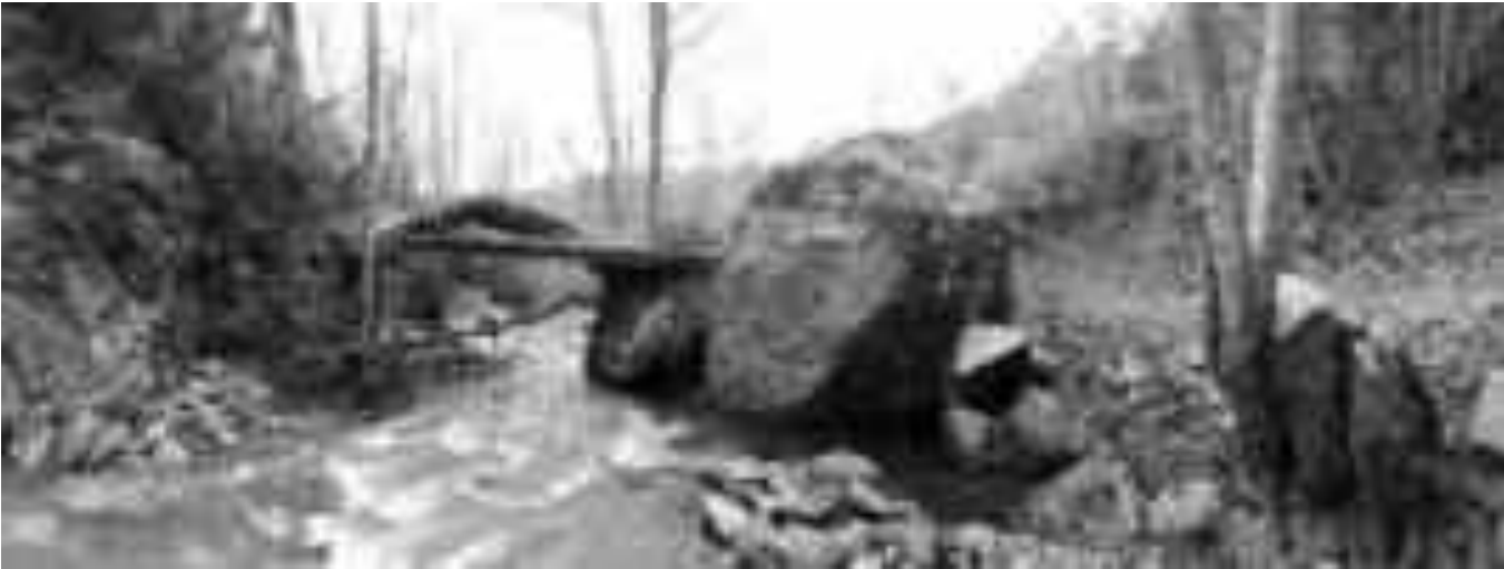
Imatge 6. Front est del pont. Font: Elaboració pròpia.
