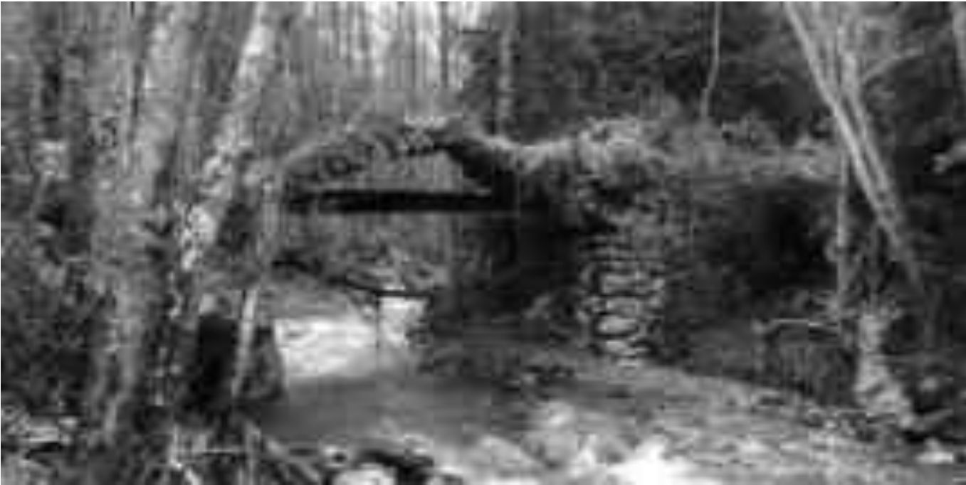
Imatge 5. Front oest del pont. Font: Elaboració pròpia.
