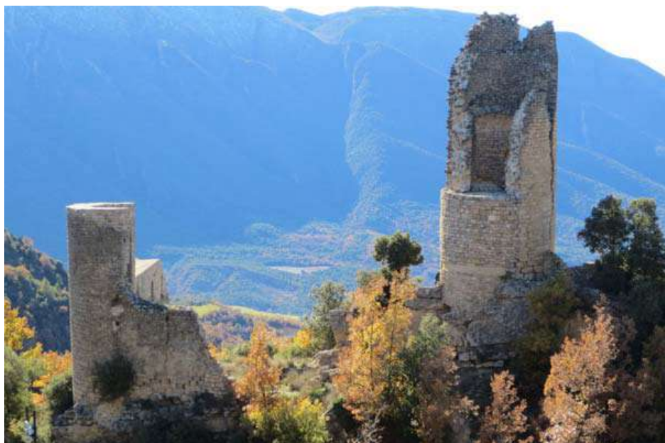
Figura 4: Torre circular del Castelló Sobirà en la que es pot observar la base rocosa sobre la que va ser construïda. A l'esquerra una de les semi-torres que formen part de la muralla perimetral. Es poden observar les actuacions realitzades per consolidar el monument al 2007.
