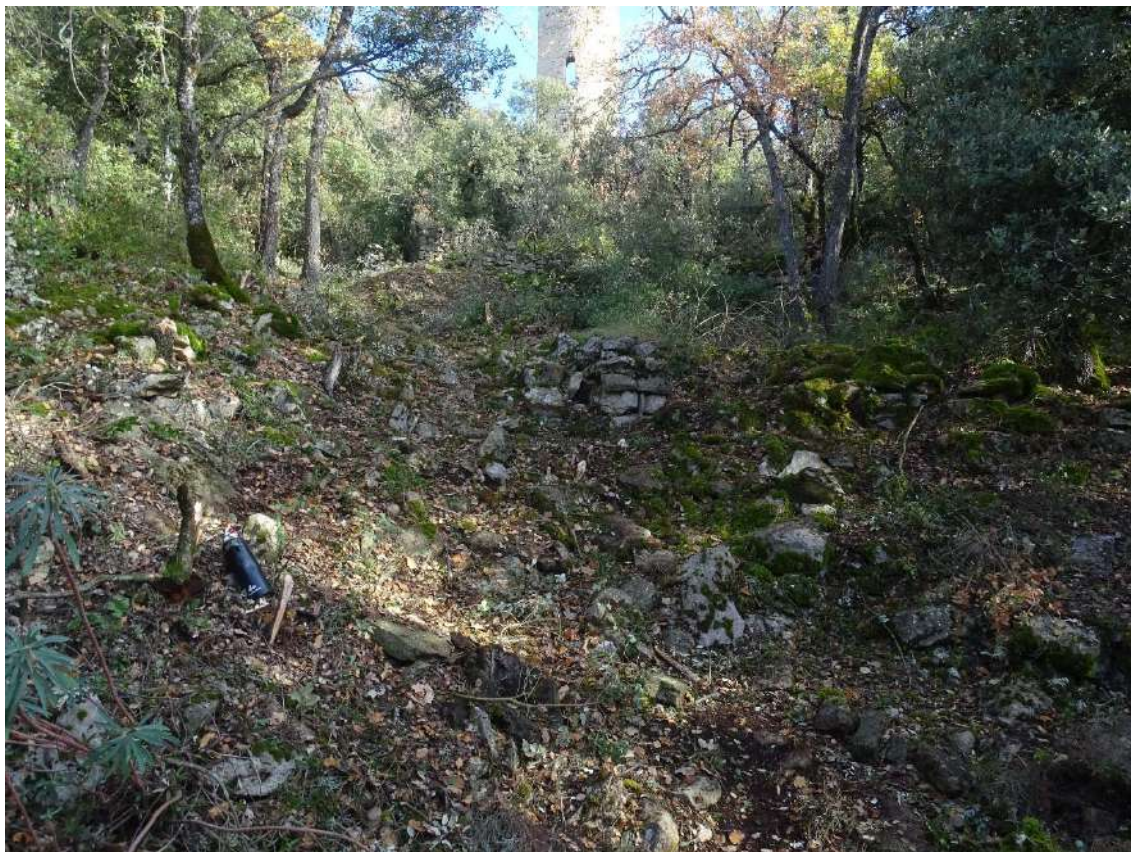
Figura 8: Tasques de desbrossament de la zona de l'hàbitat. Al fons es pot observar la torre circular amb la porta en el primer pis.
